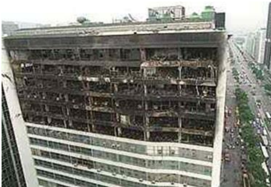
Figura 46 – estado da estrutura após o incêndio Relatório do 1º Ten BM Guastini - Comandante do 1º Socorro do GOCCG - Publicado em: 2004-03-10
