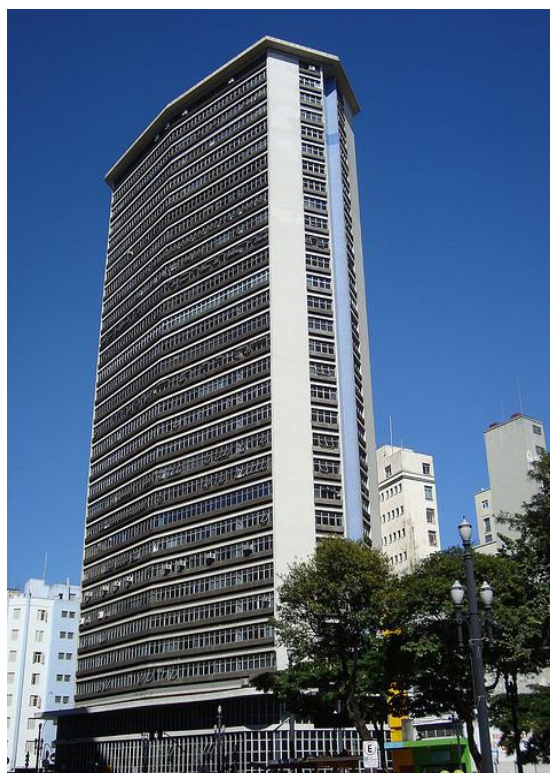
Figura 9 – Edifício Andraus atualmente
