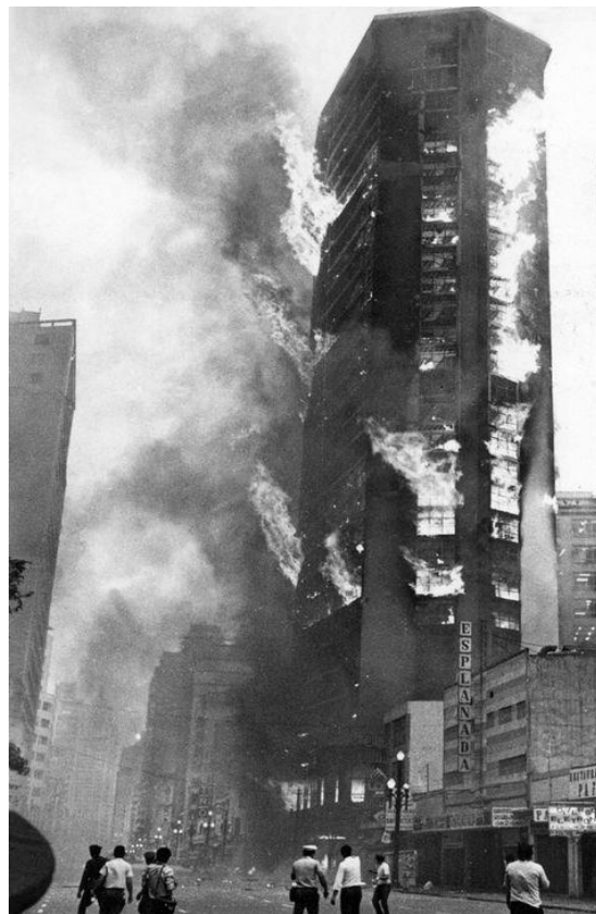
Figura 8 – Edifício Andraus no incêndio
