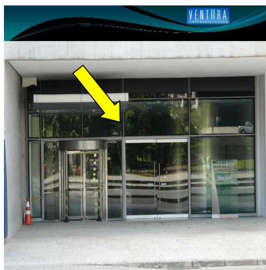
Figura 35- saídas de emergências Oeste
