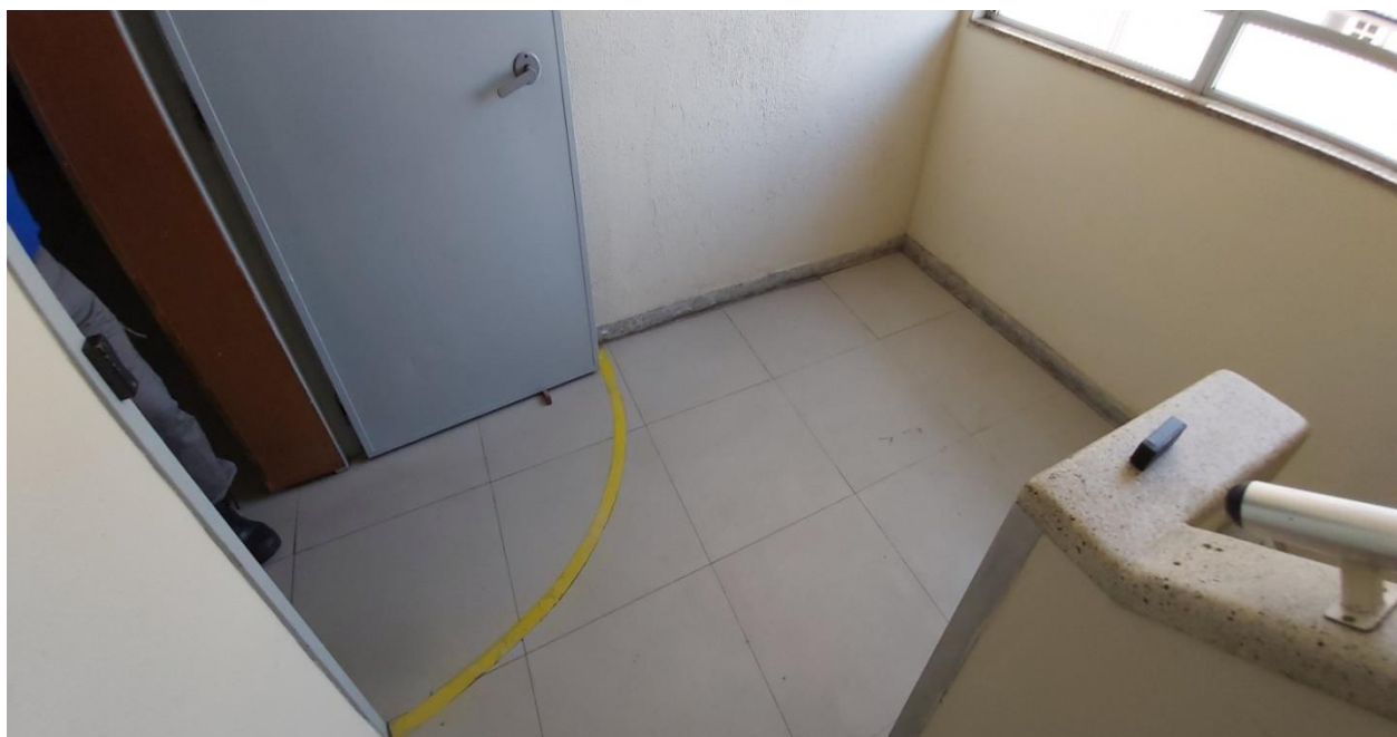
Figura 51 - Escada de emergência no 11º andar
