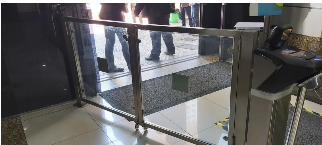
Figura 48- Portão lateral de evacuação em caso de incêndio
