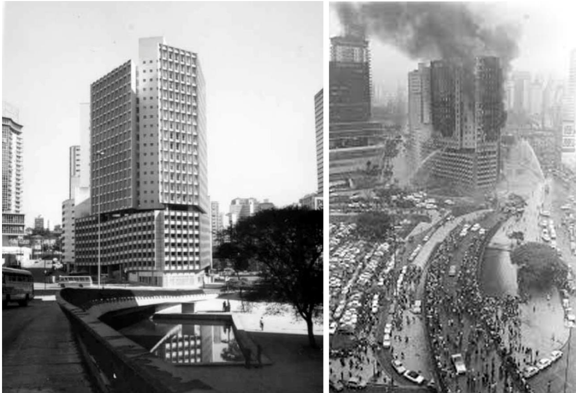
Figura 12 –Edifício Joelma antes e depois do incêndio
