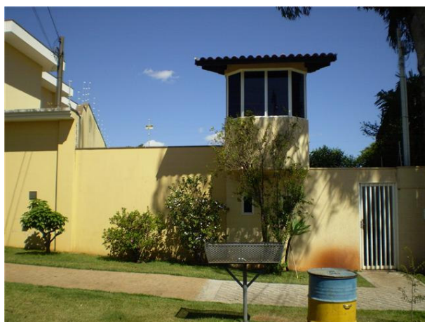
Figura 55 – Muro, cerca eléctrica e guarita Fonte: Autor
