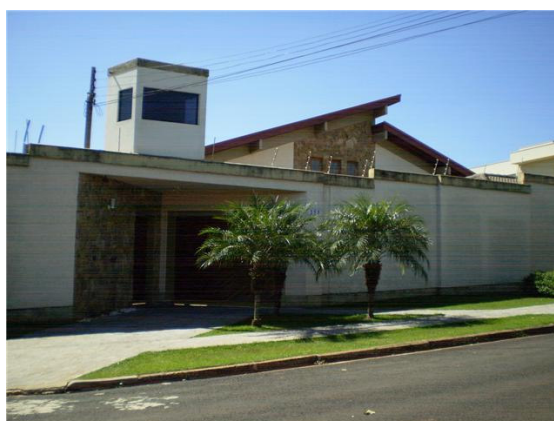
Figura 53 – Muro, cerca elétrica e guarita Fonte: Autor
