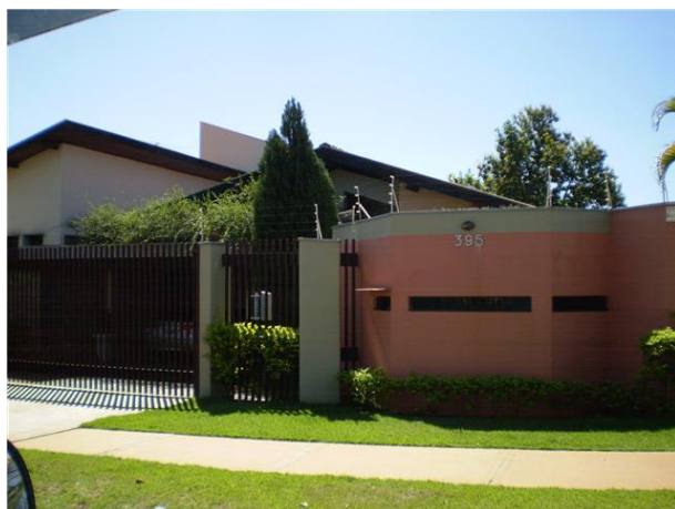
Figura 54 – Muro, cerca eléctrica e guarita Fonte: Autor
