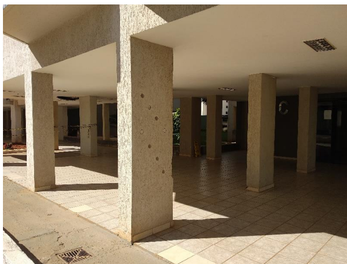
Figura 33 Pilares Bloco "C"
