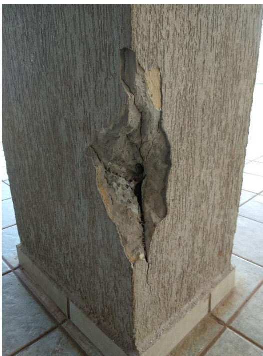
Figura 50 Cobrimento nominal do pilar do pilotis
