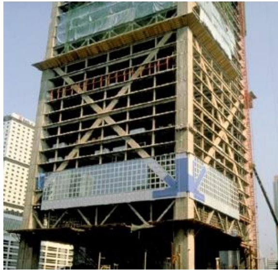
Figura 41 - Edifício Banco da China em construção (1989).
