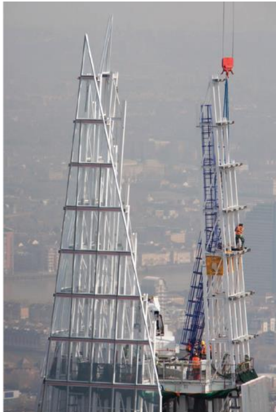
Figura 87 - Estrutura metálica do Pináculo
