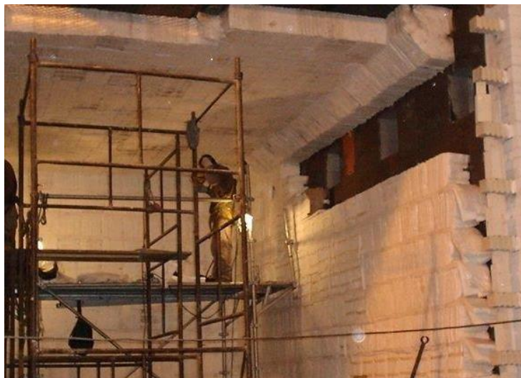
Figura 55 - Instalação da Manta de fibra Cerâmica
