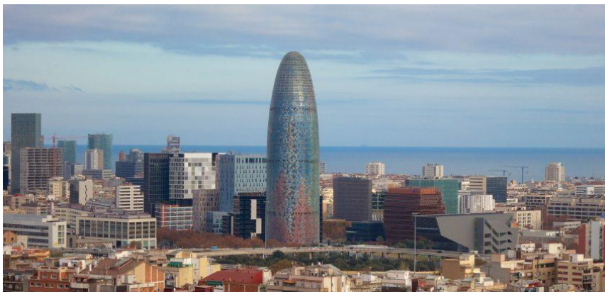
Figura 69 - Torre Agbar, Barcelona | Espanha.
