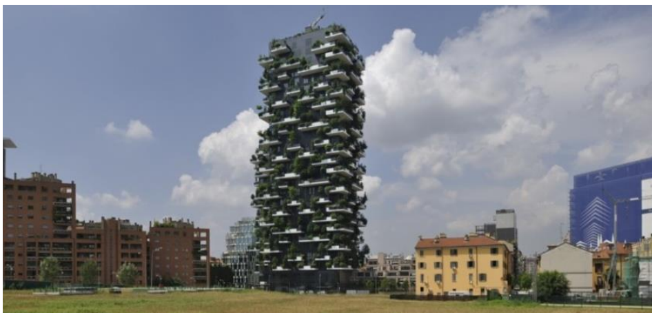
Figura 72 - Torre Bosco Verticale, Milão | Itália
