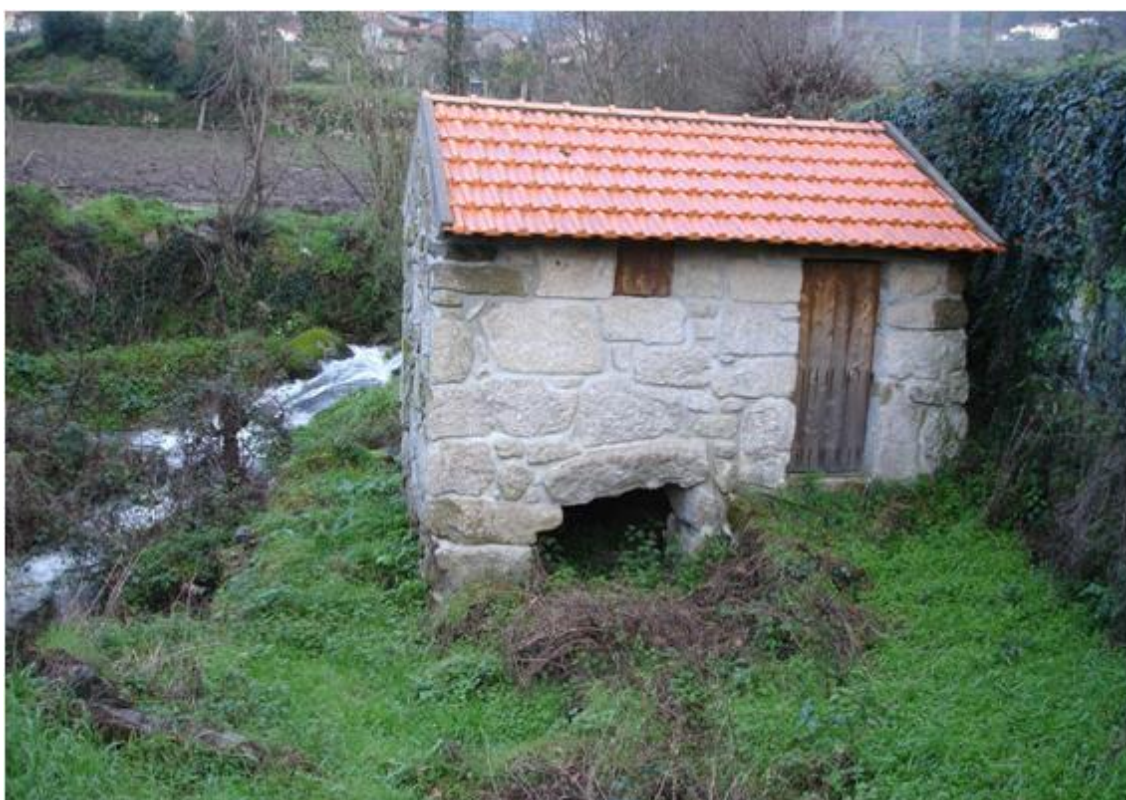
figura 90: Moinho da Ponte - foto da autora
