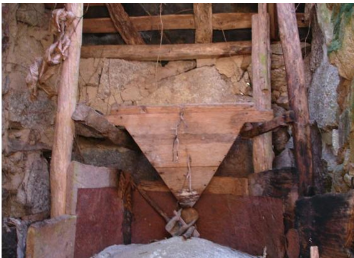
figura 65: Moinho do Pião, interior – foto da autora
