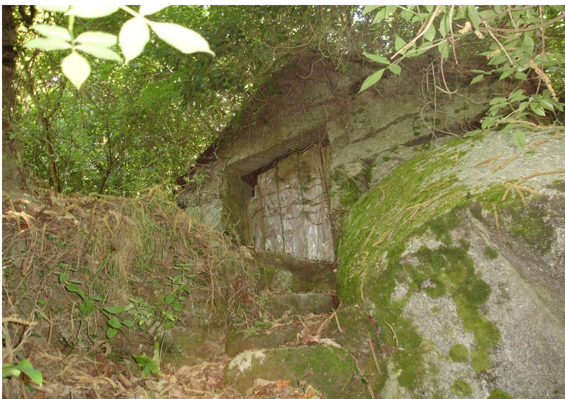
figura 52: Moinho da Vessada MM2 - fachada principal. Fonte: foto da autora
