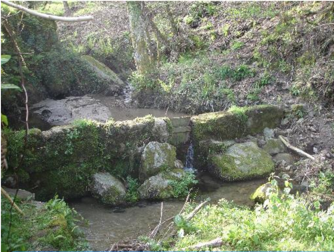
figura 12: açude a montante do moinho Cimeiro - FONTE: foto da autora
