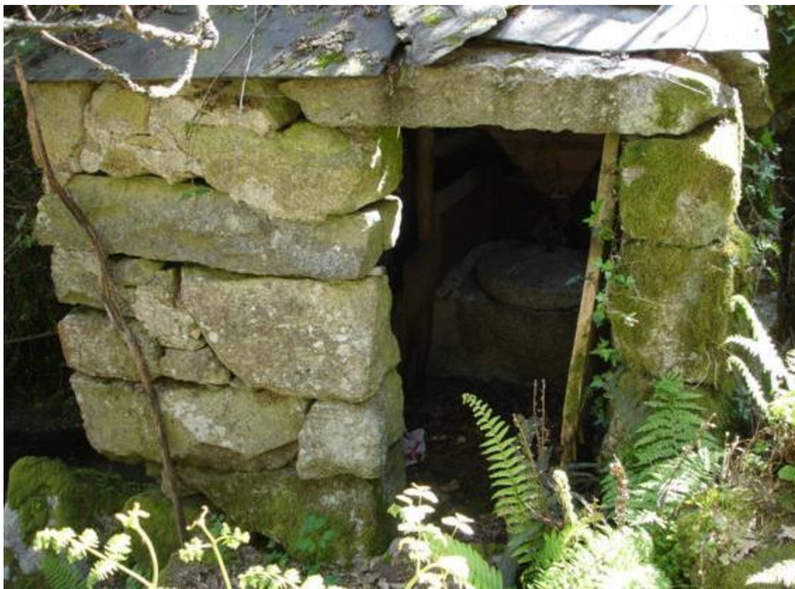
figura 64: Moinho do Pião, fachada principal – foto da autora
