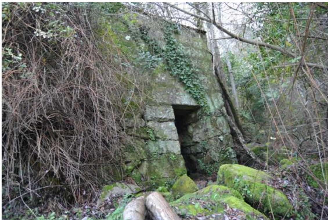
figura 42: moinho Cimeiro MM1 - fachada do cabouco. FONTE: foto de Henrique Gonçalves
