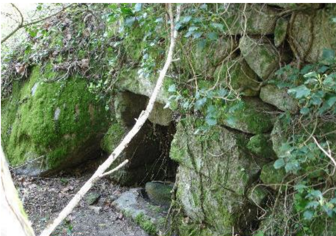
figura 51: Moinho da Vessada MM2 - fachada do cabouco. Fonte: foto da autora
