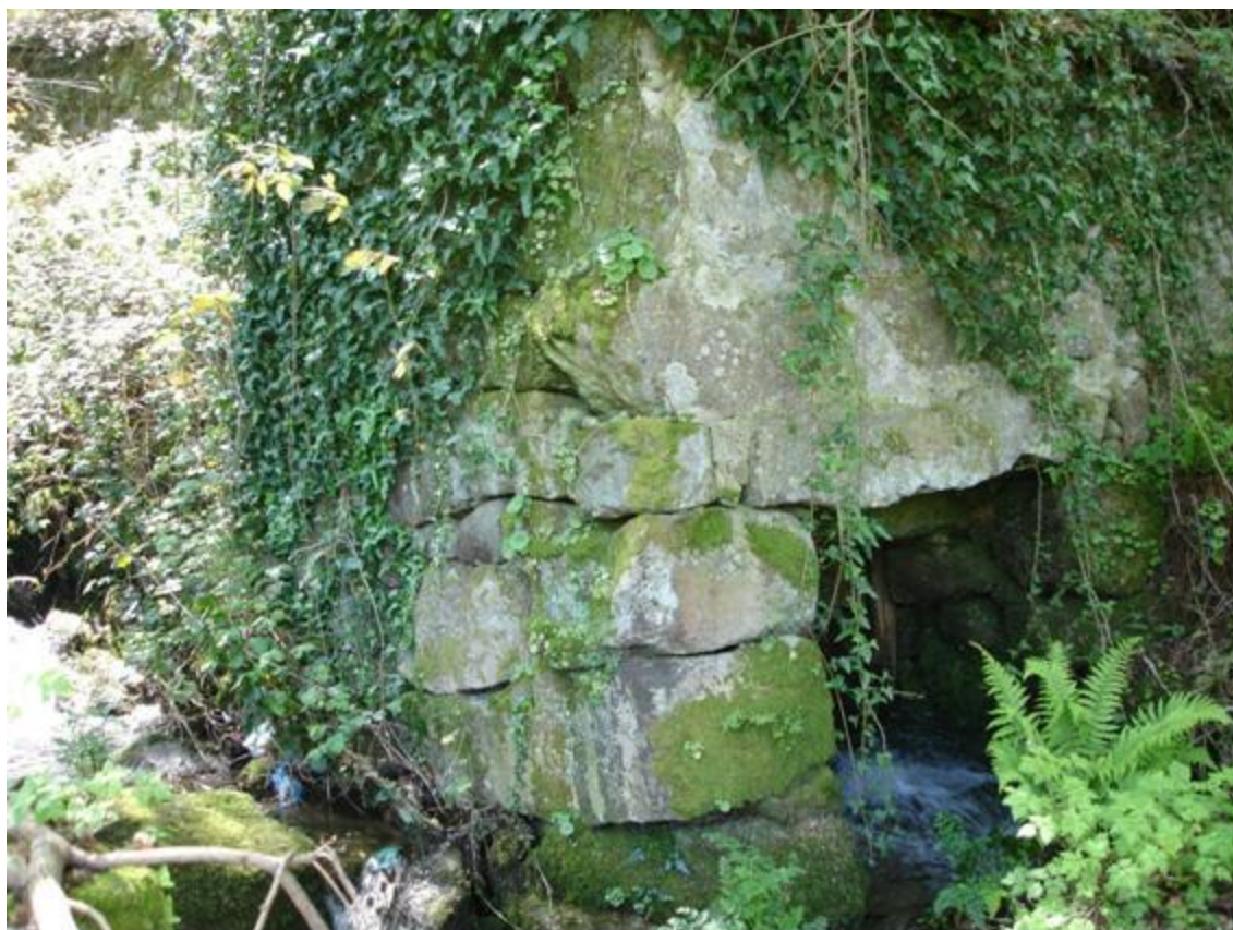
figura 69: Moinho da Carvalheira, fachada do cabouco – foto da autora
