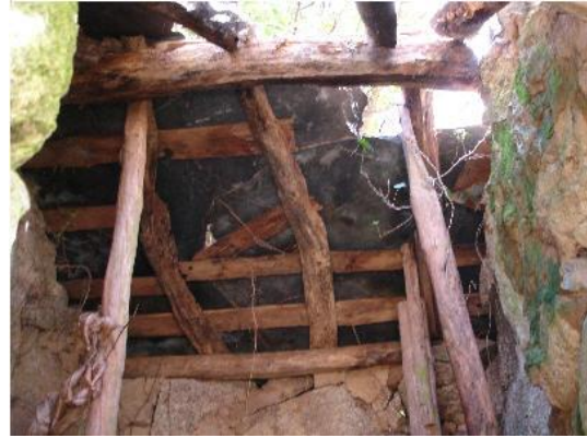
figura 26: vista interior da cobertura do moinho
