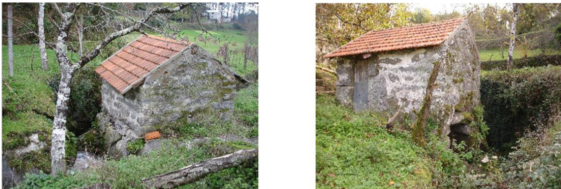
figura 124: À esquerda, fachadas lat. esquerda e posterior. À direita, fachadas lat. direita principal – fotos da autora.
