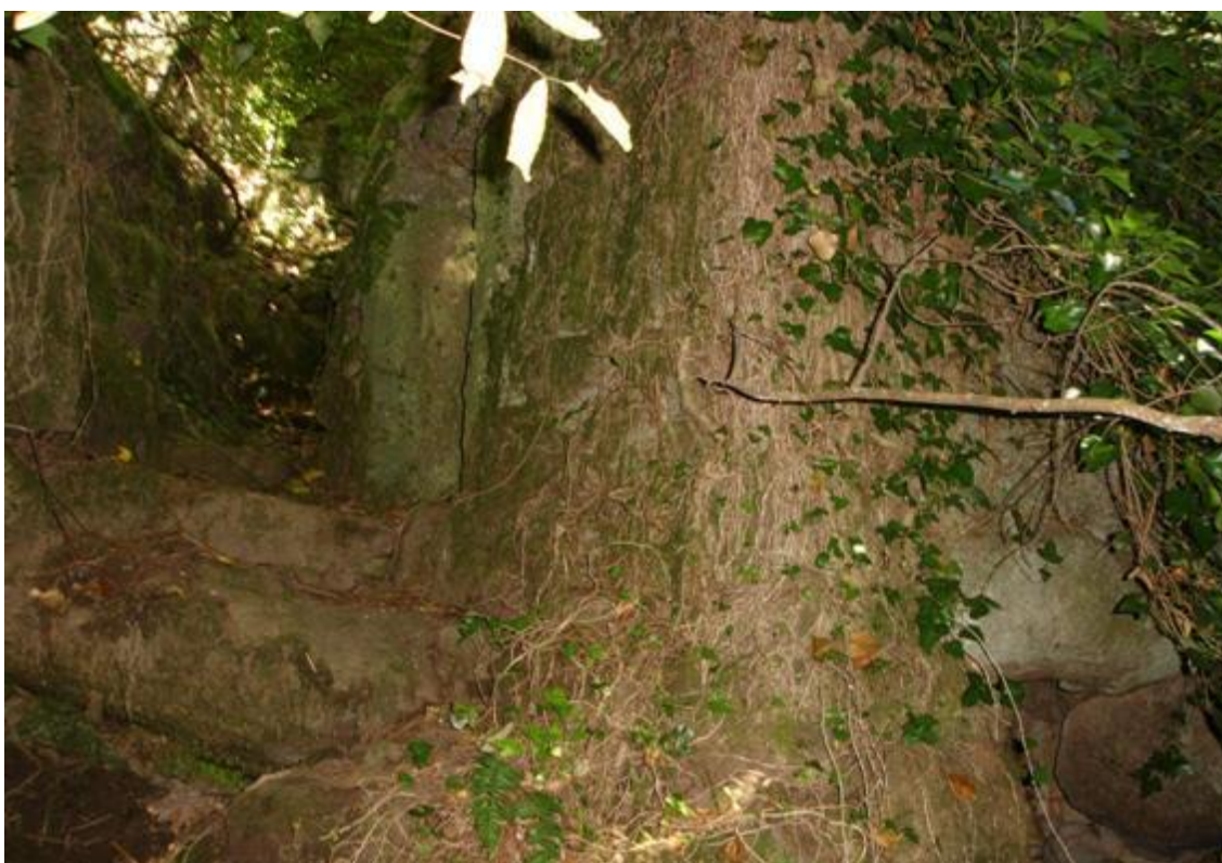
figura 56: Moinho do Buraco, acesso ao piso superior – foto da autora
