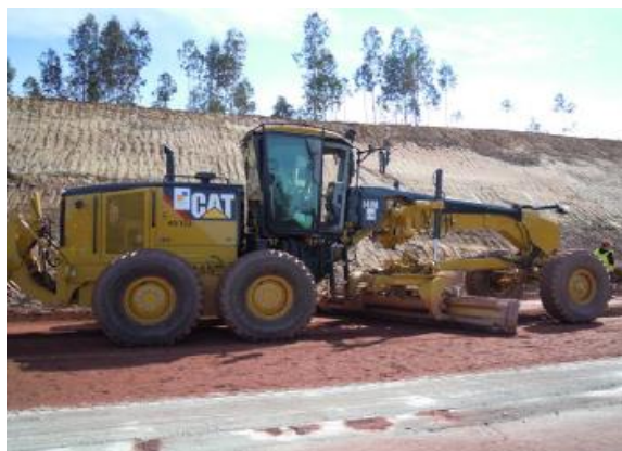
Figura VI-2 – Regularização da altura da camada
