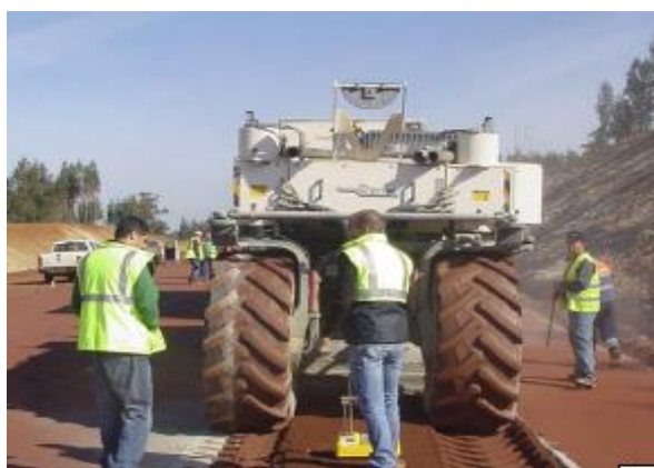
Figura VI-4 – Controlo de compactação da mistura
