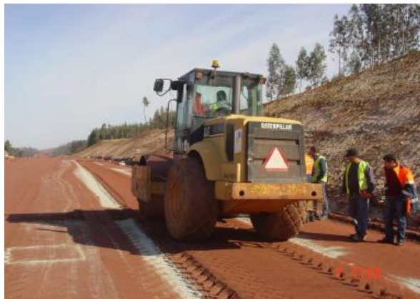
Figura VI-3 – Compactação da Mistura
