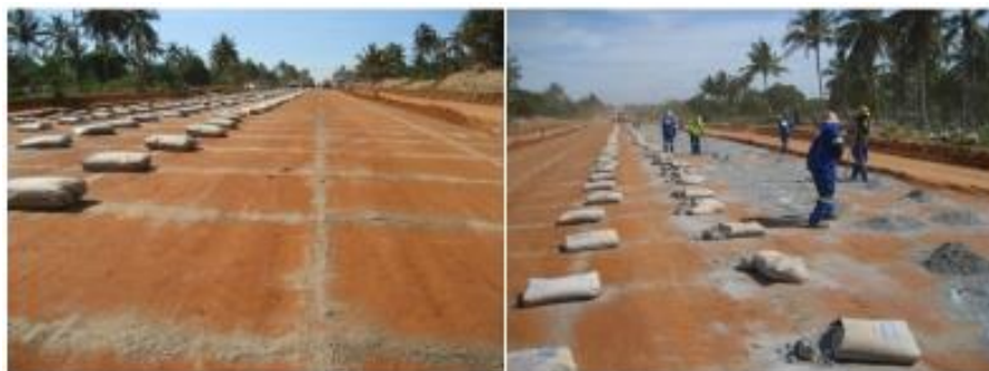
Figura V-3 – Espalhamento manual de ligante
