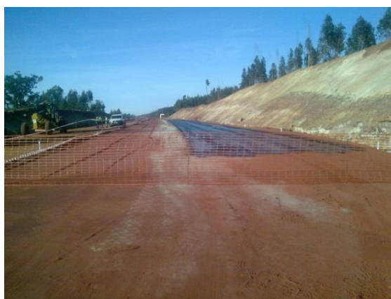
Figura V-6 – Proteção de Cura de mistura de solo-cimento
