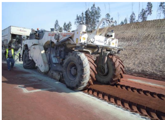
Figura VI-1 – Mistura dos materiais
