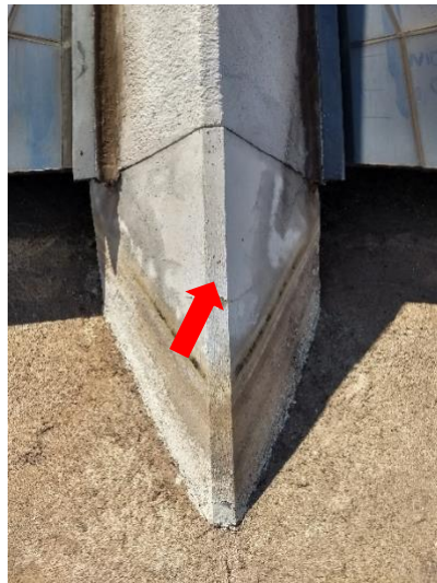
Base do Pilar 12, Fissura aproximada de 0,1 mm
