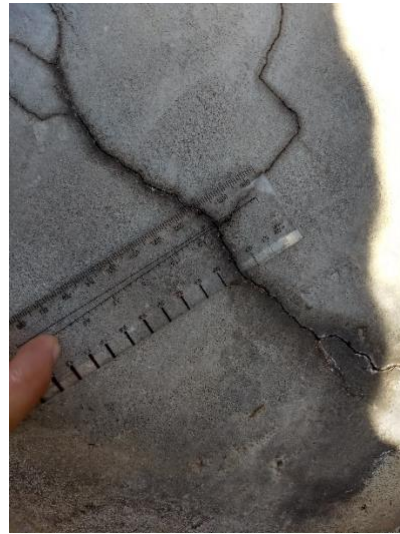
Base do Pilar 05, Fissura aproximada de 0,3 mm
