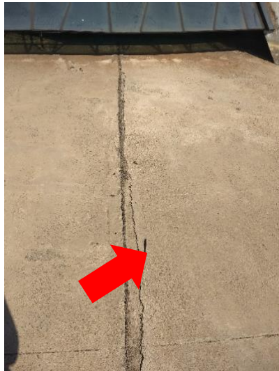
Junta de dilatação no espelho d'água
