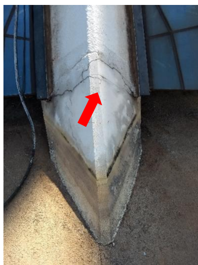
Base do Pilar 10, Fissura aproximada de 0,9 mm
