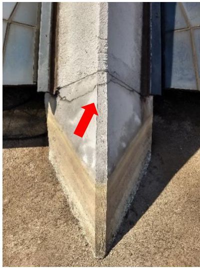
Base do Pilar 13, Fissura aproximada de 0,4 mm
