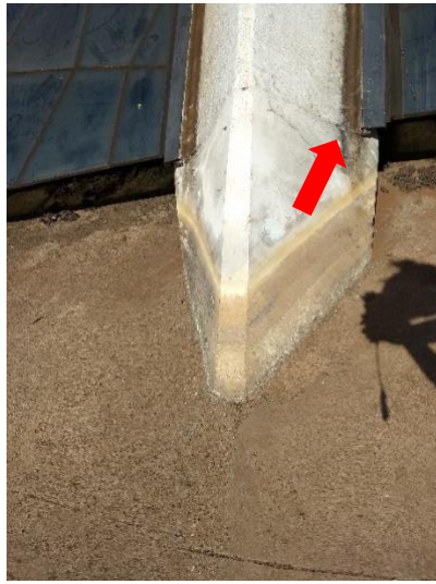
Base do Pilar 03, Fissura aproximada 0,3mm
