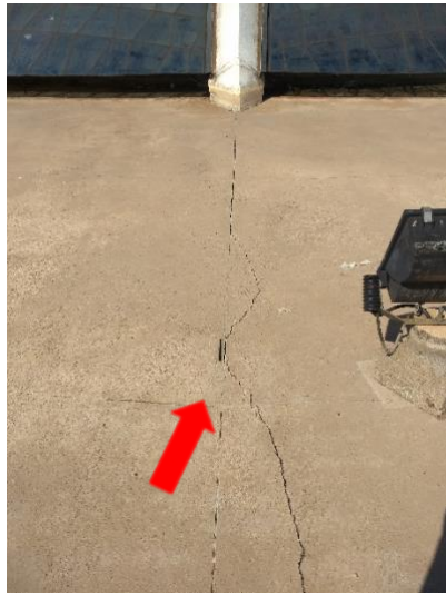
Fissura, Desplacamento
