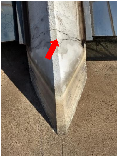
Base do Pilar 07, Fissura aproximada de 1,4 mm
