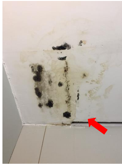
Deslocamento do revestimento
