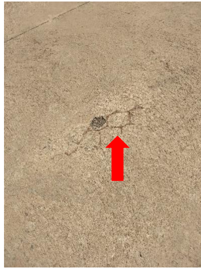
Fissura, Desplacamento
