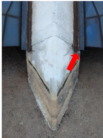
Base do Pilar 11, Fissura aproximada de 0,3 mm
