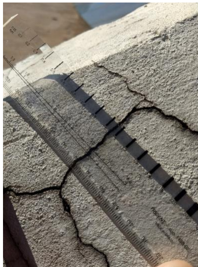
Base do Pilar 01, Fissura aproximada de 1,0 mm
