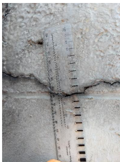
Base do Pilar 10, Fissura aproximada de 0,9 mm
