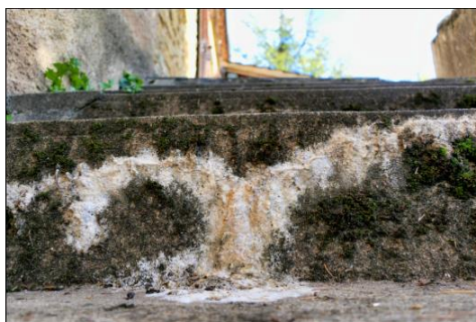
Figura 4 - Eflorescência (hrpremo.com.br)
