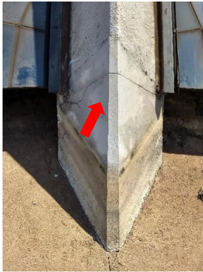
Base do Pilar 09, Fissura aproximada de 0,5 mm
