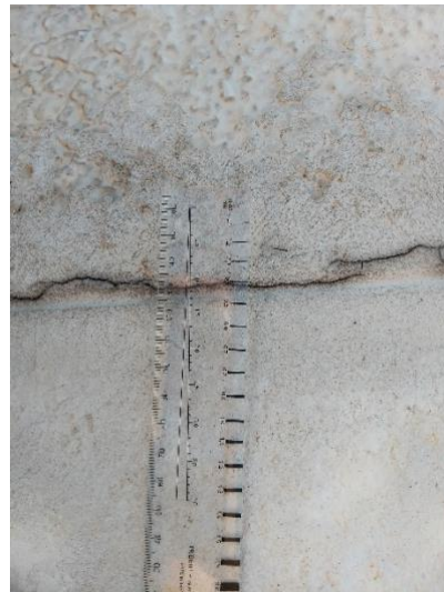
Base do Pilar 08, Fissura aproximada de 0,4 mm
