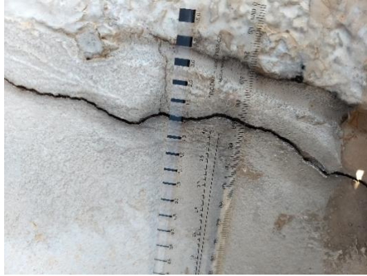
Base do Pilar 07, Fissura aproximada de 1,4 mm
