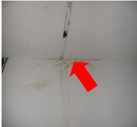
Manchas de infiltração na junta de dilatação
