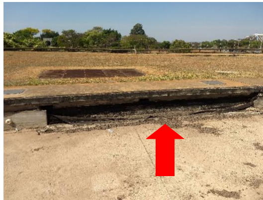
Fissura, Desplacamento
