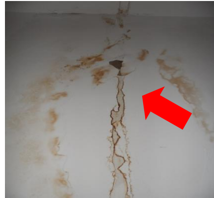
Manchas de infiltração na junta de dilatação
