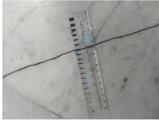
Trinca ao redor do altar, medida da trinca
