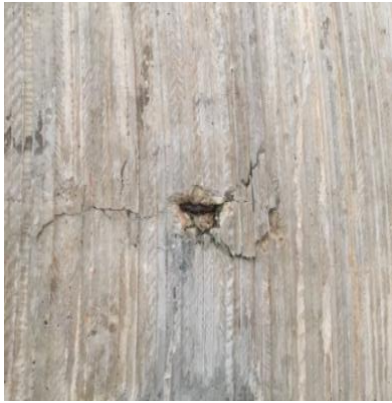
Desplacamento e corrosão da armadura e Eflorescência
