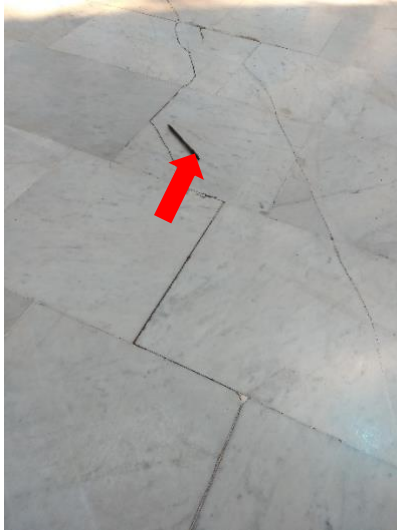
Trinca ao redor do altar, medida da trinca
