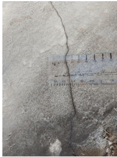
Base do Pilar14, Fissura aproximada de 0,2 mm
