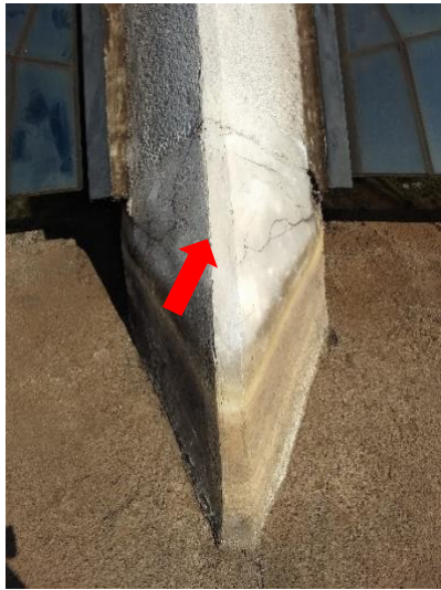
Base do Pilar 05, Fissura aproximada de 0,3 mm
