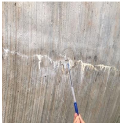
Desplacamento e corrosão da armadura e Eflorescência
