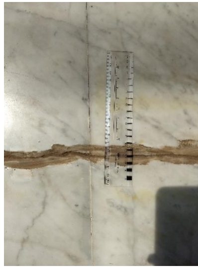
Trinca da Entrada principal, medida da trinca.
