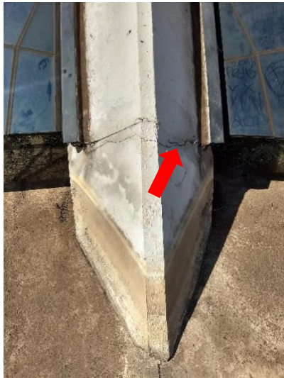
Base do Pilar 15, Fissura aproximada de 0,6 mm
