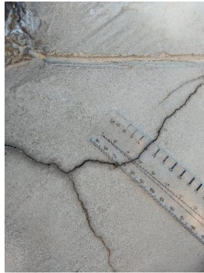
Base do Pilar 09, Fissura aproximada de 0,5 mm
