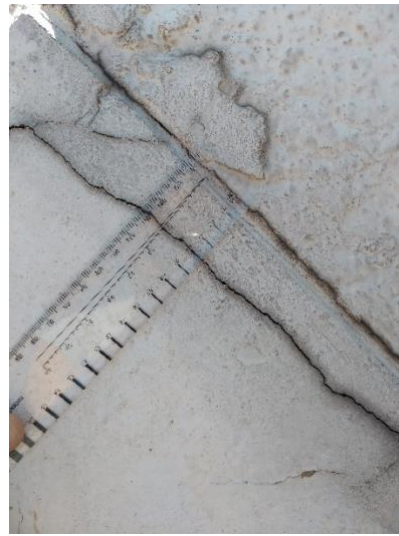
Base do Pilar 13, Fissura aproximada de 0,4 mm
