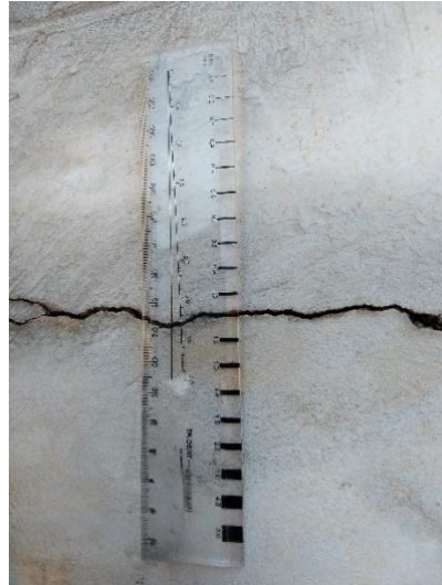
Base do Pilar 16, Fissura aproximada de 1,1 mm
