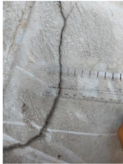
Base do Pilar 02, Fissura aproximada de 0,2 mm
