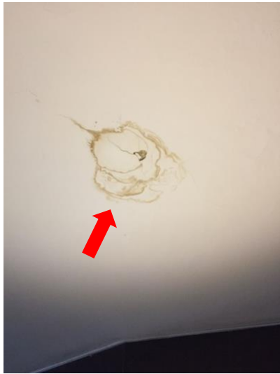
Deslocamento do revestimento
