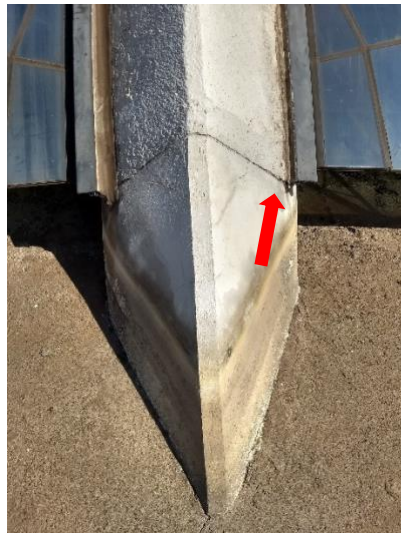
Base do Pilar 06, Fissura aproximada de 0,1 mm
