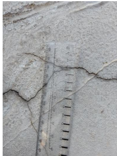
Base do Pilar 11, Fissura aproximada de 0,3 mm
