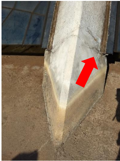
Base do Pilar 02, Fissura aproximada de 0,2 mm
