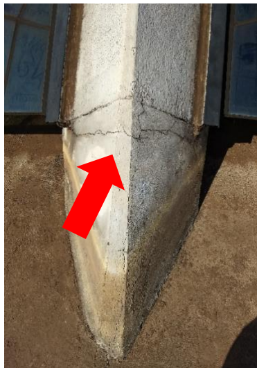
Base do Pilar 01, Fissura aproximada de 1,0 mm
