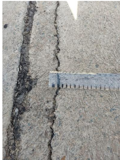
Junta de dilatação no espelho d'água
