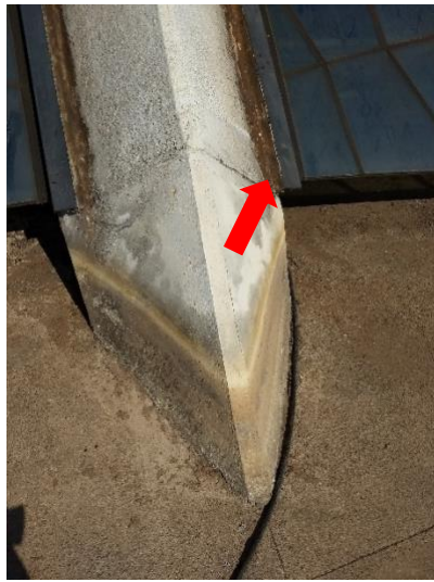
Base do Pilar 04, Fissura aproximada de 0,1 mm
