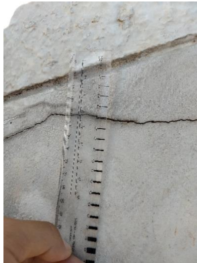
Base do Pilar 15, Fissura aproximada de 0,6 mm
