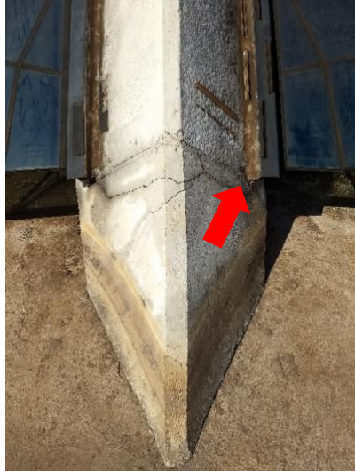
Base do Pilar 16, Fissura aproximada de 1,1 mm
