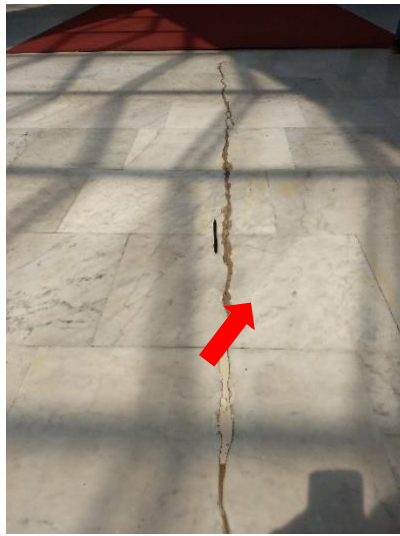
Trinca da Entrada principal, medida da trinca.
