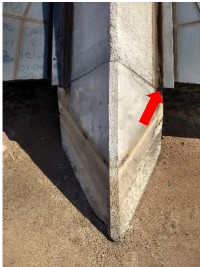
Base do Pilar 08, Fissura aproximada de 0,4 mm
