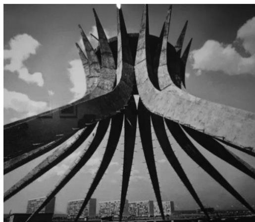
Figura 11 – Vista dos pilares ainda na fase de construção
