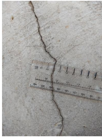
Base do Pilar 03, Fissura aproximada 0,3mm
