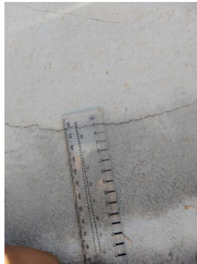
Base do Pilar 12, Fissura aproximada de 0,1 mm
