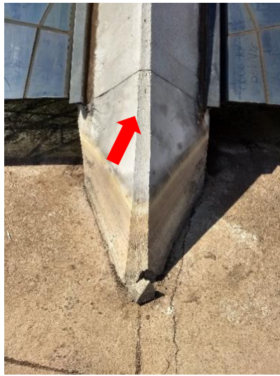
Base do Pilar14, Fissura aproximada de 0,2 mm
