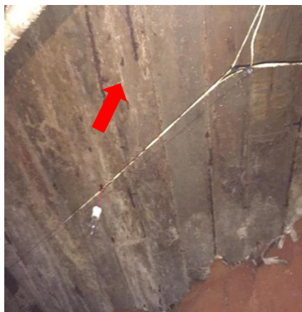
Laje Espelho d'água (interno/por baixo)
