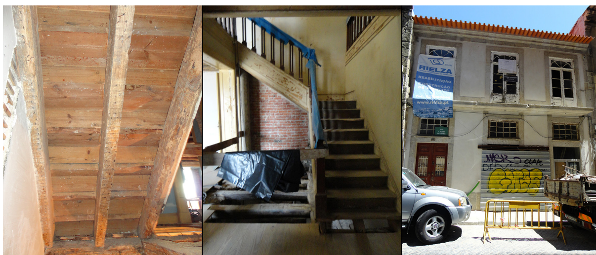
Fig. 37. Estrutura das escadas com 3 vigas perna. Fig. 38. Escada de 2 lanços. Fig. 39. Exemplo dos lancis de pedra em torno de todas as aberturas na fachada principal.
