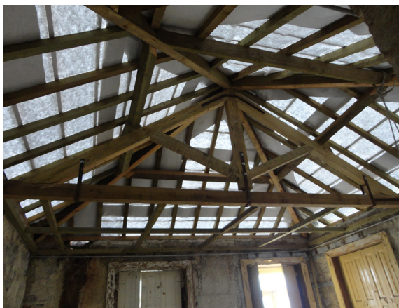
Fig. 34. Estrutura corpo 2 toda refeita na íntegra.
