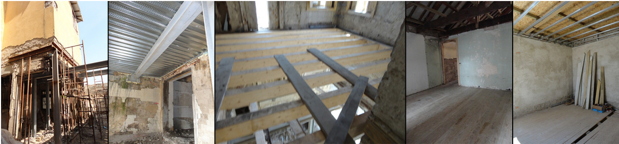
Fig. 25. Reforço de paredes através de vigas metálicas. Fig. 26. Laje colaborante a substituir a antiga laje de betão armado. Fig. 27. Corpo do edifício no alçado posterior com o vigeamento todo substituído. Fig. 28. Revestimento do pavimento a soalho. Fig. 29. Revestimento do teto a celenite.
