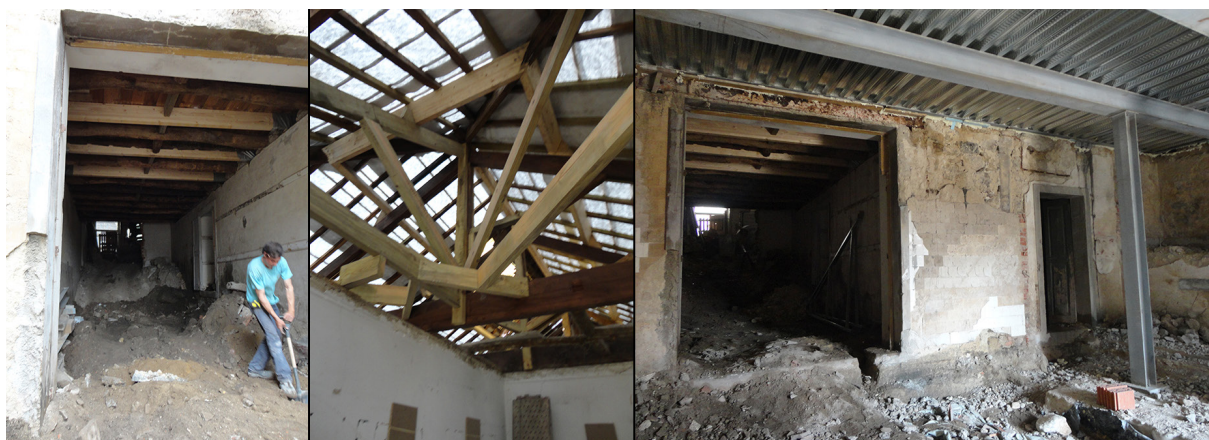
Fig. 2. Vigas substituídas. Fig. 3. Elementos cobertura substituídos. Fig. 4. Laje metálica.
