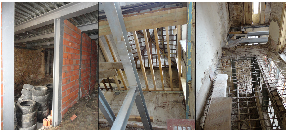
Fig. 5. Pilares metálicos cave. Fig. 6. Estrutura nova pavimento corpo 2 piso 1. Fig. 7. Estrutura do pavimento no corpo 2 r/c executado da mesma forma da laje metálica.
