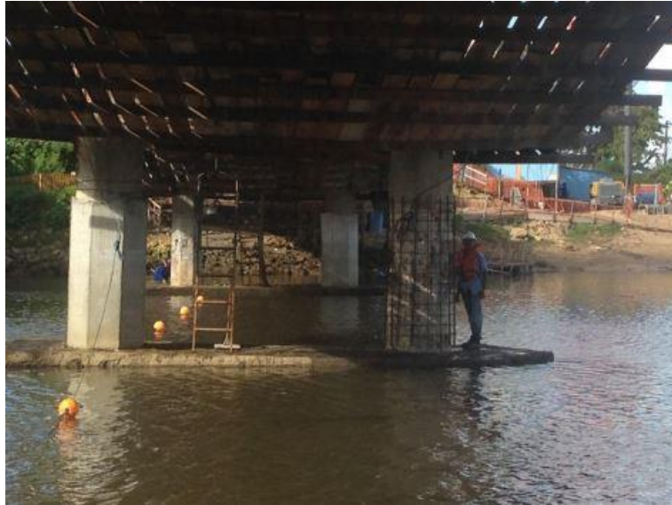
Figura 27: Superposição de armadura no pilar da ponte [50].
