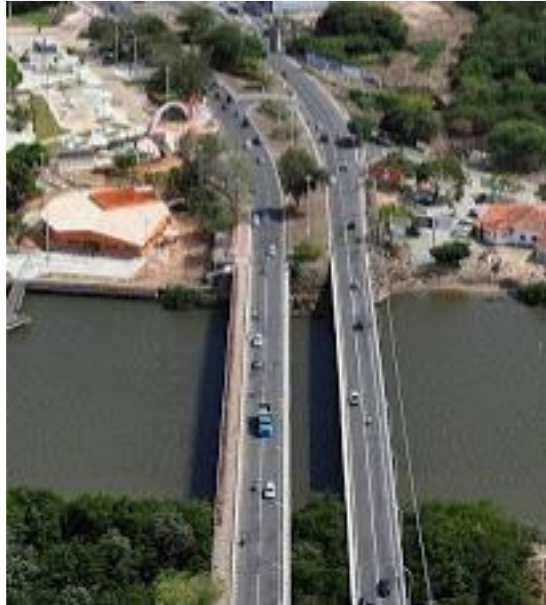
Figura 22: Ponte da direita Juscelino Kubitschek, em direção a Orla, e a esquerda Ponte Paulo Barreto Menezes em direção ao centro de Aracaju [49].
