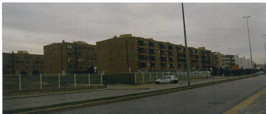
Figura 97 - Unidade de Gestão Urbanística 3 Fonte: Autor (2012).
