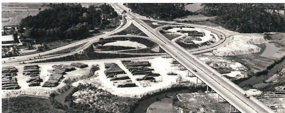
Figura 62 - Viaduto do Leça Fonte: Arquivo Histórico Municipal de Matosinhos.
