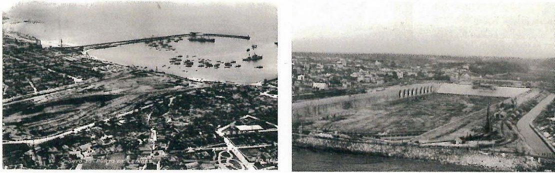
Figuras 50 - 51 - Escavação do Porto de Leixões Fonte: Arquivo do Autor.
