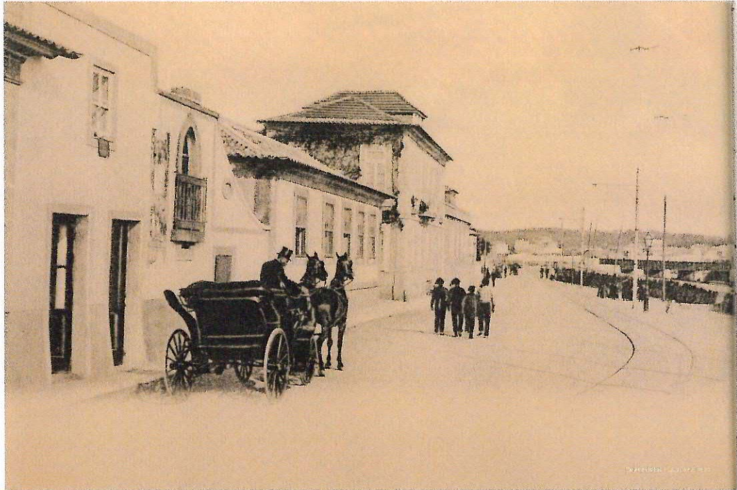
Figura 30 - A "Sala de Visitas" Fonte: Santos, F. (2012, p.8).
