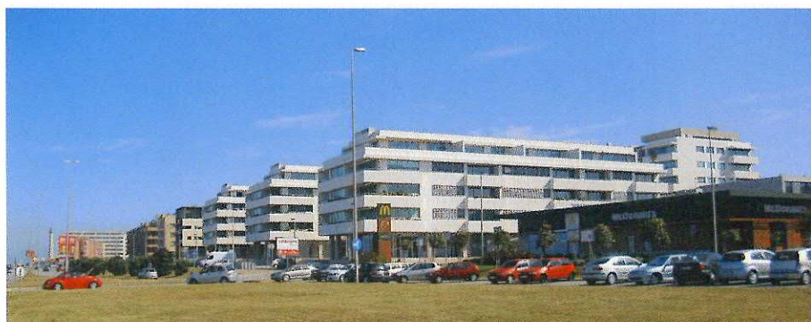
Figura 99 - Unidade de Gestão Urbanística 5 Fonte: Autor (2012).
