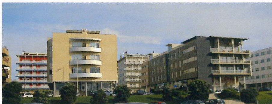
Figura 98 - Unidade de Gestão Urbanística 4 Fonte: Autor (2012).
