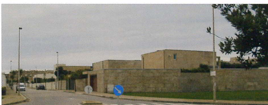
Figura 100 - Unidade de Gestão Urbanística 6 Fonte: Autor (2012).
