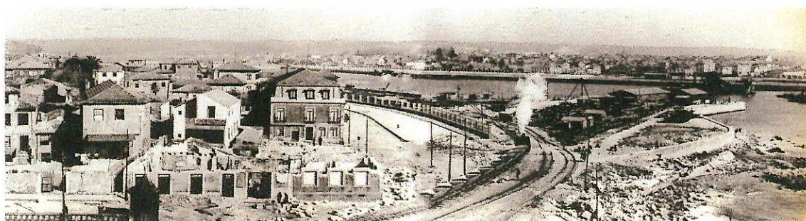
Figura 49 - Demolições para ampliação do Porto de Leixões Fonte: Catálogo da Exposição “Leixões: Identidade e Memória de um porto” (2003, p.9).
