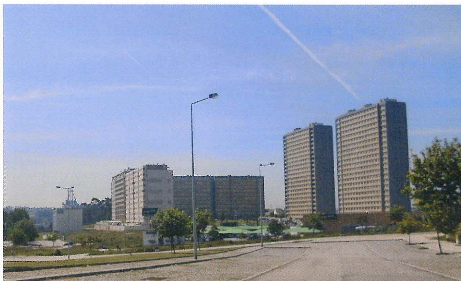
Figura 130 - Unidade de Gestão Urbanística 23 – Terrenos da antiga FACAR Fonte: Autor (2012).
