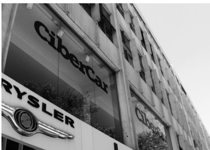
Figura 27 - Diferente perspetiva da fachada da rua Delfim Ferreira Fonte - Avelino Oliveira, 2012, p. 66
