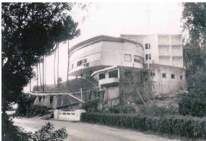
Figura 30 - Adaptação a Estalagem em fase de construção Fonte - Manuel Pinto, 2012, p. 60
