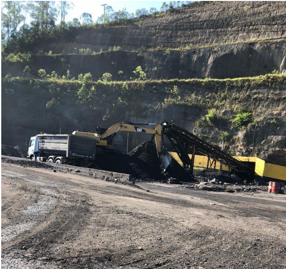
Figura 26 – Foto da Mina Lauro Muller, Santa Catarina, Brasil, onde a extração do carvão é realizada pela construção de túneis.
