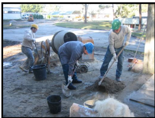
Fig. II.2. - Fabrico de argamassa
