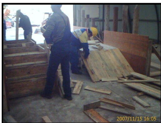
Fig. II.19 - Descofragem
