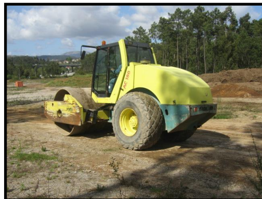
Fig. II.33 . Compactação com vibração
