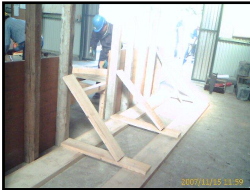
Fig. II.15 – Colocação de patamares
