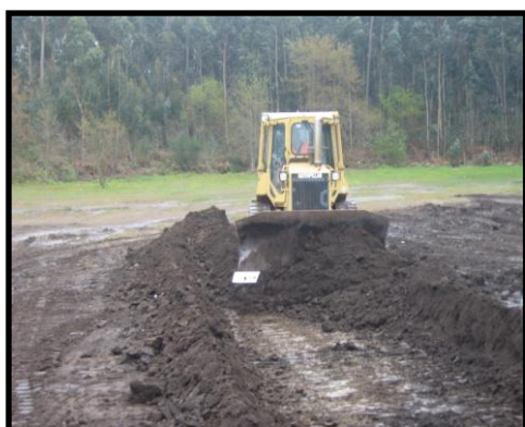
Fig. II.26 - Enchimento da caixa
