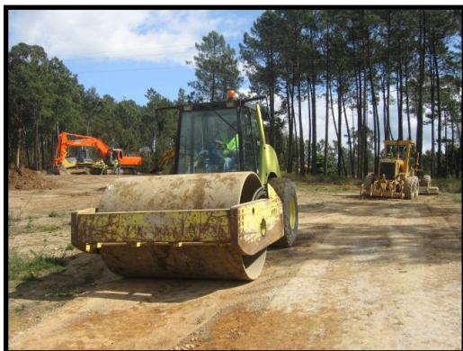
Fig. II.32 – Compactação simples
