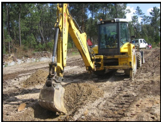
Fig. II.21 – Abertura de sapata
