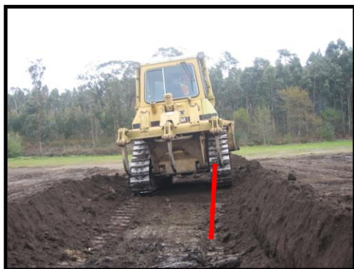
Fig. II.24 – Abertura de caixa
