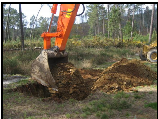
Fig. II.34 – Abertura de sapata
