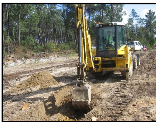
Fig. II.23 – Abertura de vala
