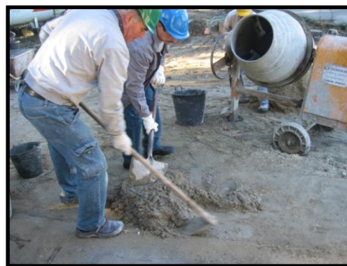
Fig. II.3. – Aspecto final da argamassa
