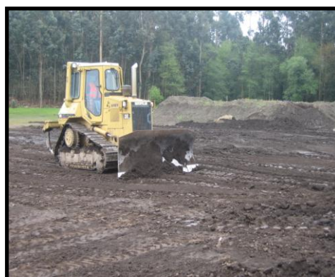
Fig. II.27 – Nivelamento do terreno
