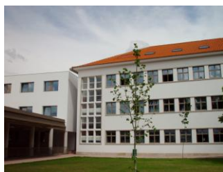
foto 11 - Bloco aulas e Informática
