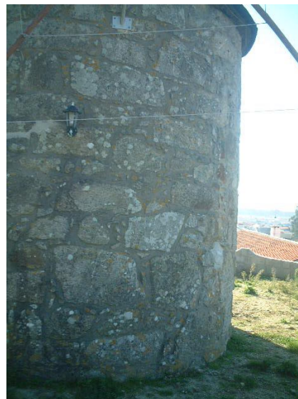
Figura 31 - Alvenaria com junta. Fonte: Autor
