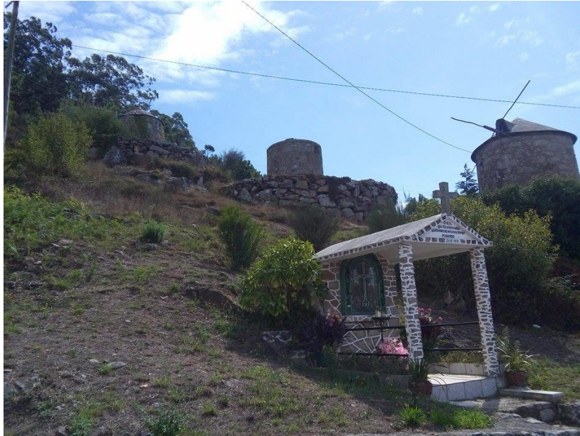
Figura 27 - Patamares de suporte dos moinhos. Fonte: Autor
