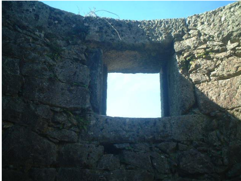
Figura 32 - Abertura de vão (Janela). Fonte: Autor
