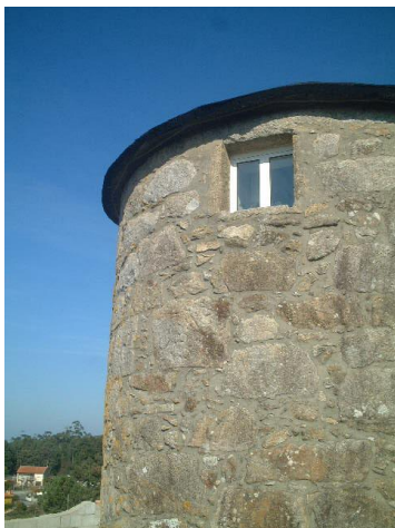
Figura 33 - Aplicação de janela em alumínio. Fonte: Autor
