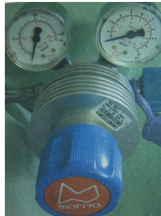
Fig. 7 e 8 – Válvulas reguladoras de pressão de O 2 e N 2 O, respectivamente (retirado de Falqueiro 2005)
