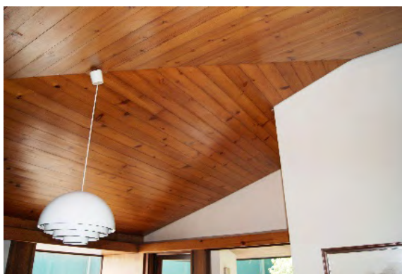
Figura 22. A Casa de Gaia: tecto do quarto. Fonte: fotografia de Ana Rita Moreira.
