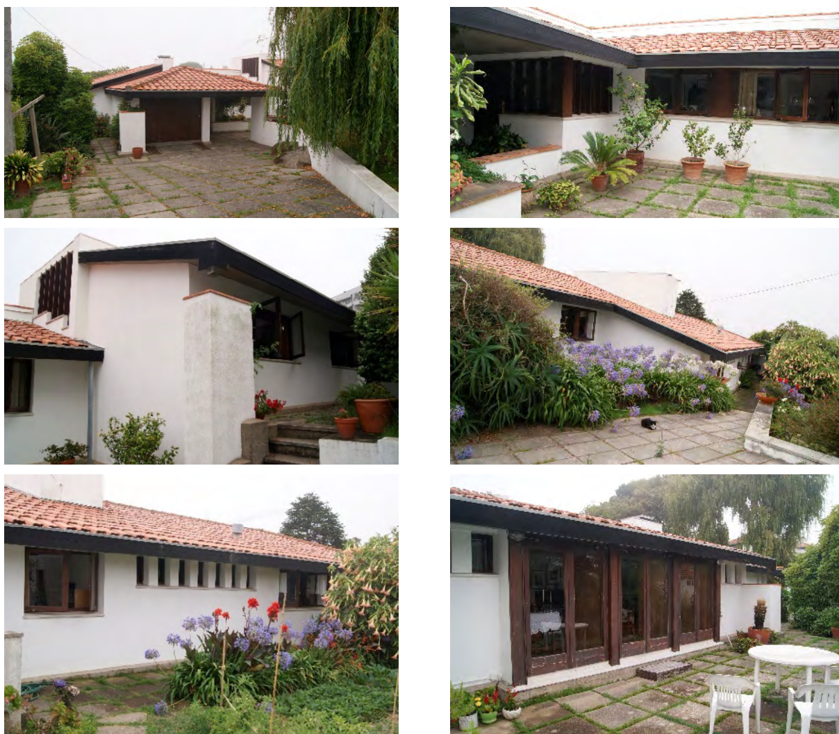
Figura 16. Vistas do exterior da Casa de Gaia: fachadas parciais. Da esquerda para a direita e de cima para baixo: 16.1 Vista desde a entrada no lote para a garagem/entrada (Fachada SE); 16.2 Vista sobre o pátio central e as janelas das salas de trabalho (Fachada SE); 16.3 Vista sobre o corpo dos quartos (Fachada SE); 16.4 Vista desde o pátio da casa junto ao anexo projectado em 1995 (Fachada N-NO); 16.5 Vista sobre o corpo dos serviços (Fachada NO); 16.6 Vista sobre o pátio da casa que prolonga a sala comum para o exterior (Fachada SO) | Fonte: fotografias de Ana Rita Moreira
