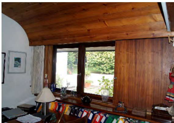
Figura 20. A Casa de Gaia: tecto do escritório (prolongado na zona dos vãos e parede). Fonte: fotografia de Ana Rita Moreira.
