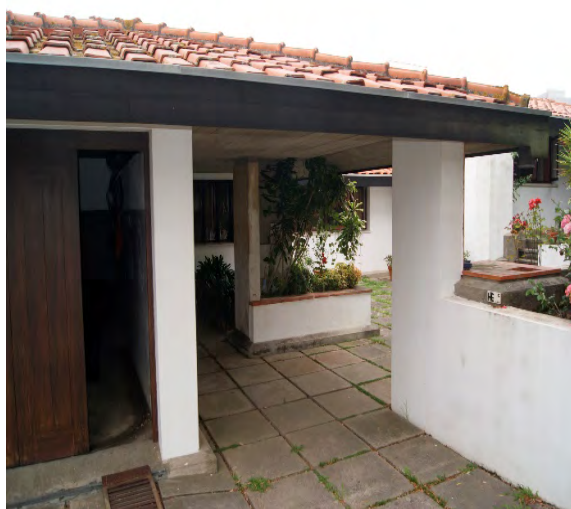
Figura 17. O embasamento em betão que circunda a casa e o pavimento em lajetas de argamassa de cimento. Fonte: fotografia de Ana Rita Moreira.
