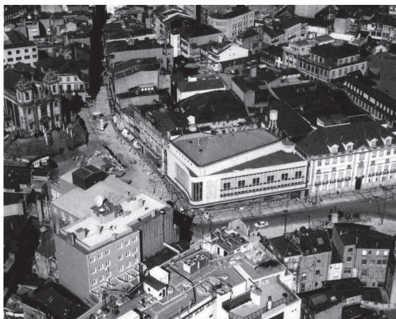
Figura. 1 – O Cinema Batalha na cidade
