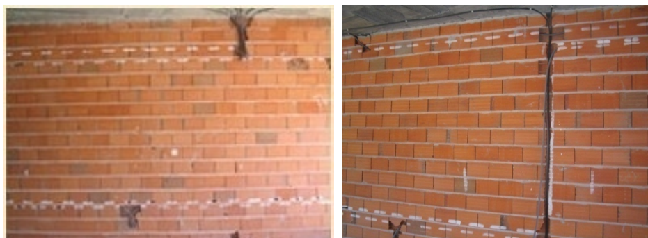
Figura 25 – Passagem de tubagem (Fonte: http://www.construcer.com . Março, 2009).
