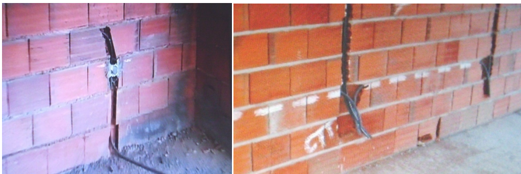
Figura 31 – Abertura de roços (Fonte Própria. Março, 2009).
