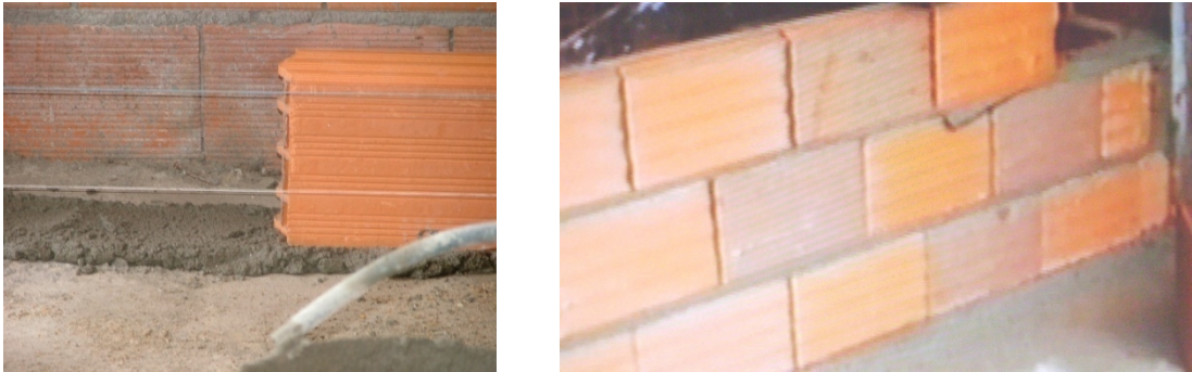
Figura 29 – Implantação de paredes interiores (Fonte Própria. Março, 2009).
