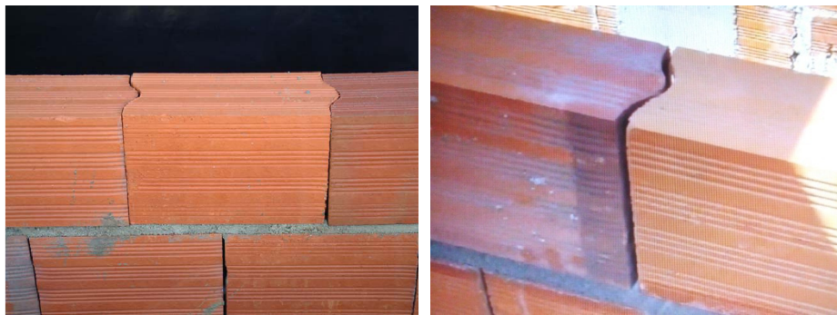
Figura 17 – Tecnotijolo sem junta vertical (Fonte: http://www.construcer.com , Março, 2009).
