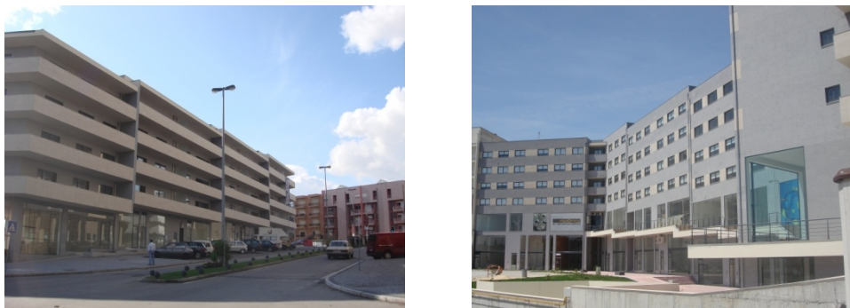
Figura 26 – Empreendimento Lousadapark (Fonte Propria. Maio, 2009).
