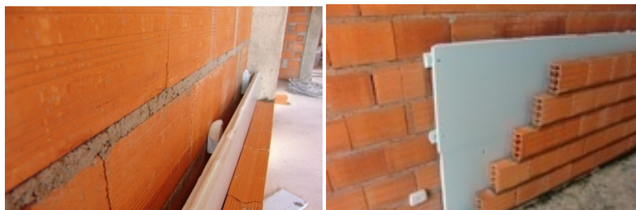
Figura 23 – Parede dupla com caixa-de-ar (Fonte: http://www.construcer.com , Março, 2009).
