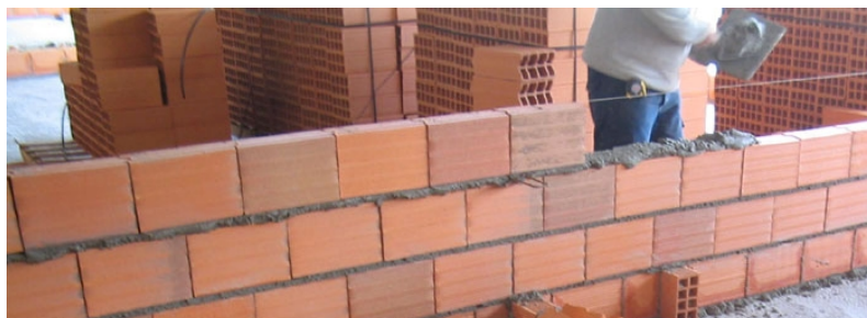
Figura 24 – Tecnotijolo sem junta vertical (Fonte: http://www.construcer.com , Março, 2009).
