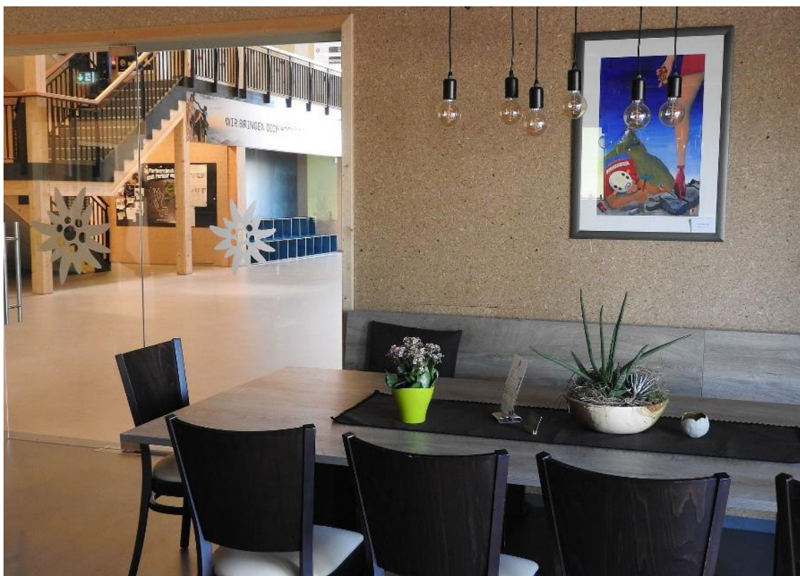
Figura 55 - Uso de Aglomerado de partículas no revestimentos de paredes
