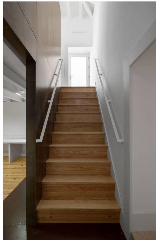
c. Uso do CBPB no revestimento de paredes
