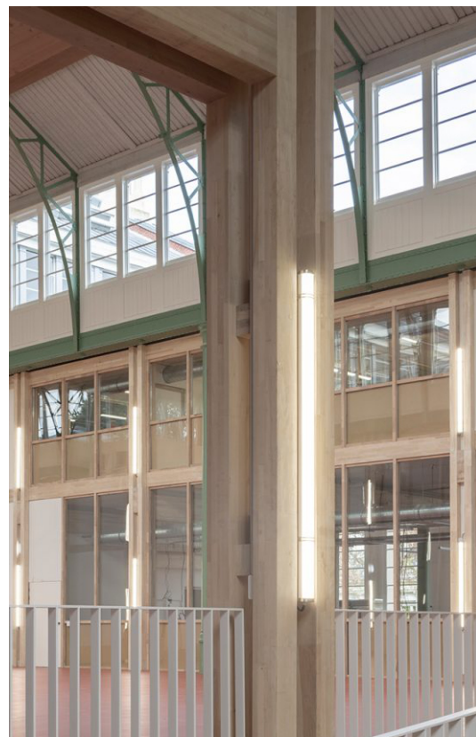
c. Pormenor de um pilar em MLC
