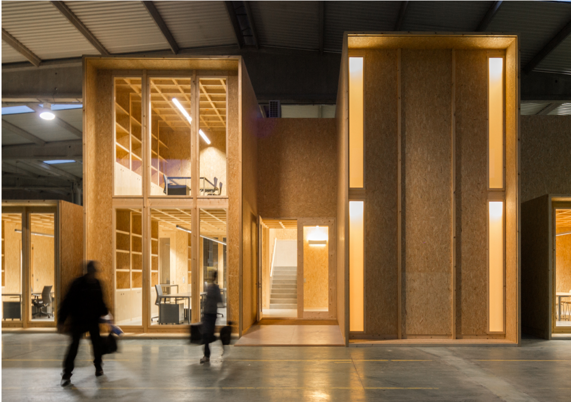
a. Vista exterior do uso do OSB nos vários elementos que fazem parte do edifício
