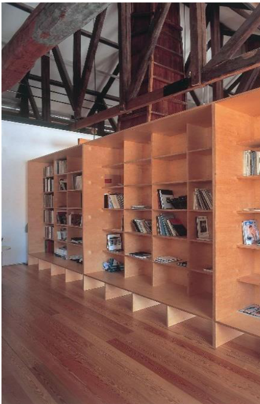
b. Uso do contraplacado em mobiliário
