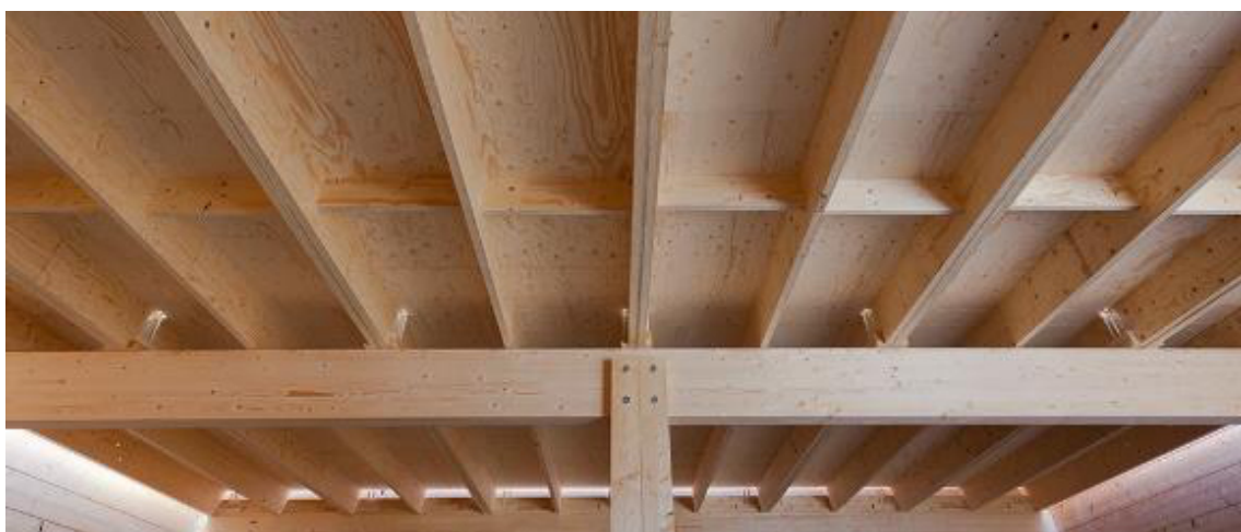
Figura 23 - Uso do LVL numa estrutura de piso
