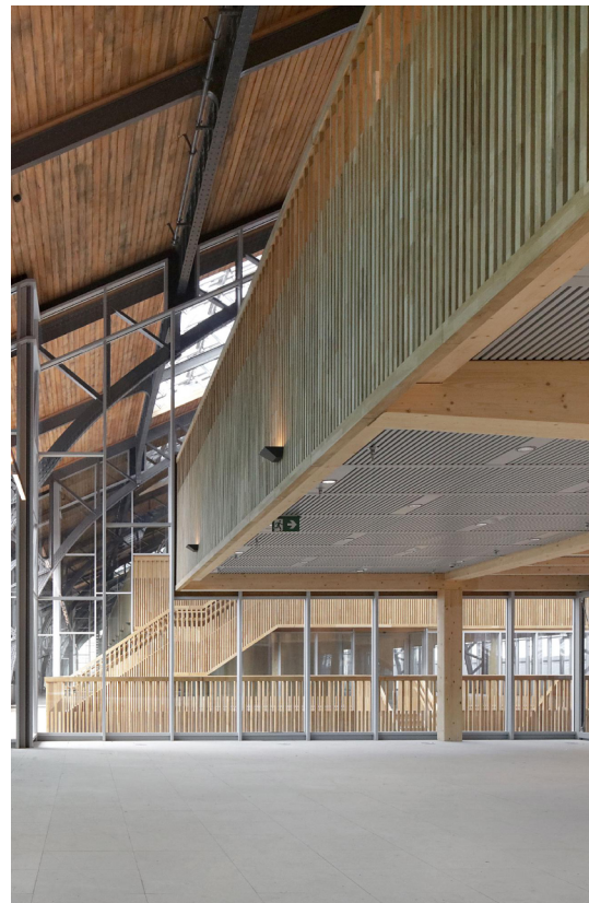
c. Uso do CLT nas várias partes do projeto
