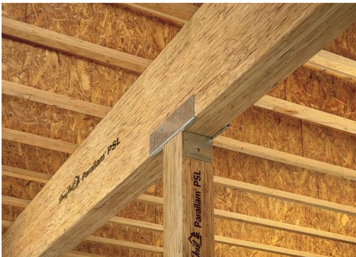
Figura 26 - Viga e coluna de PSL
