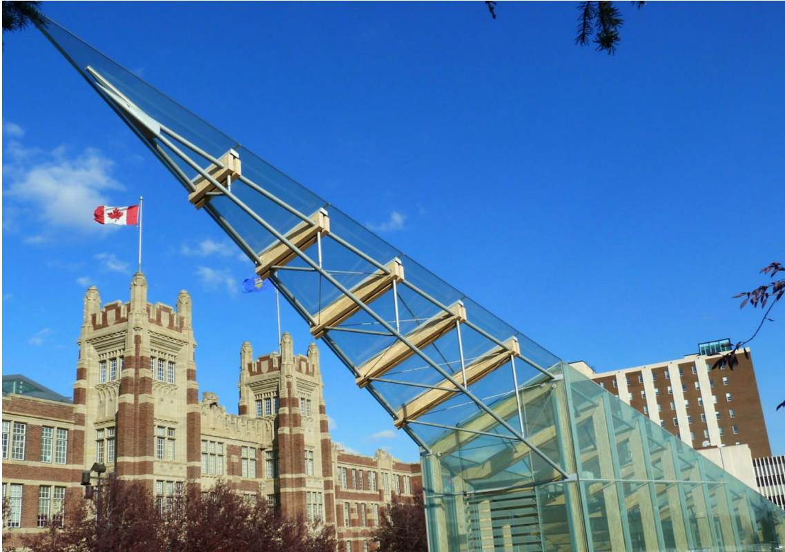
Figura 32 - Uso de vigas LSL para fixação dos painéis de vidro
