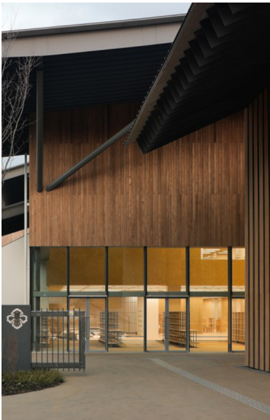
b. Vista do exterior do aglomerado nas paredes
