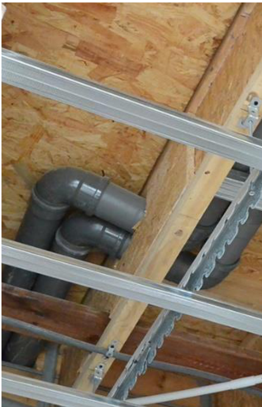
b. Pormenor da facilidade da aplicação de tubagens
