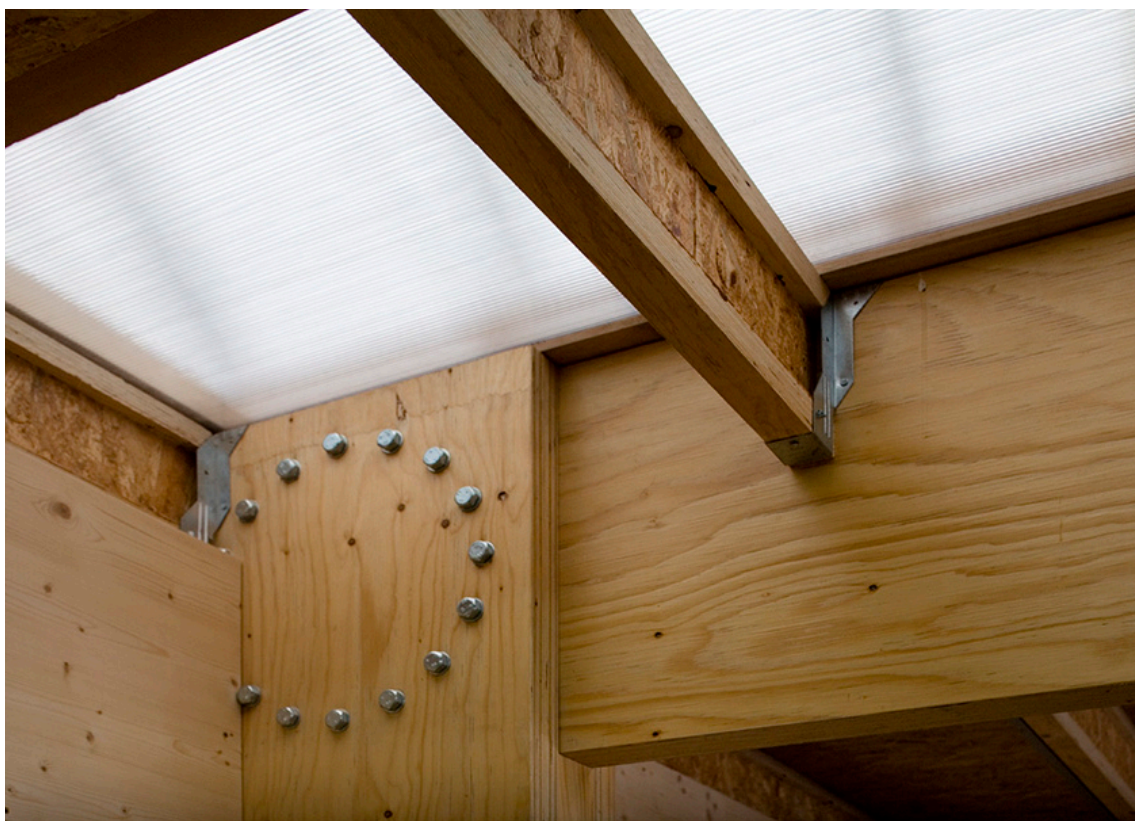
Figura 41 - Pormenor da ligação da viga I com a estrutura
