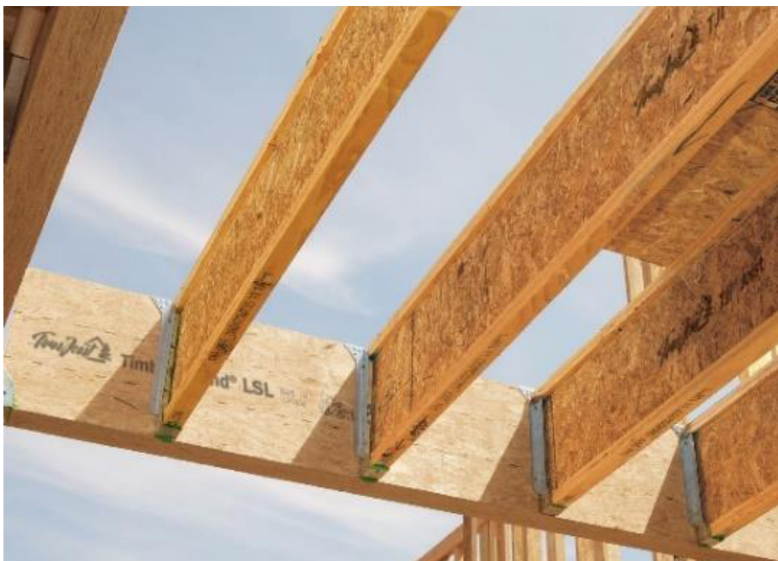
Figura 31 - Viga de LSL
