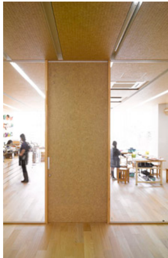
c. Uso do aglomerado no revestimento das portas
