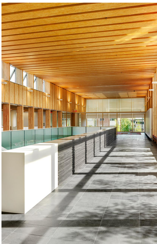
b. Vista das vigas LSL no teto
