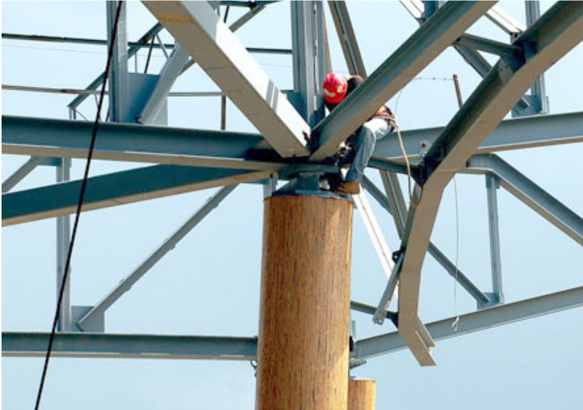
Figura 27 - Pormenor da ligação da estrutura com o pila de PSL
