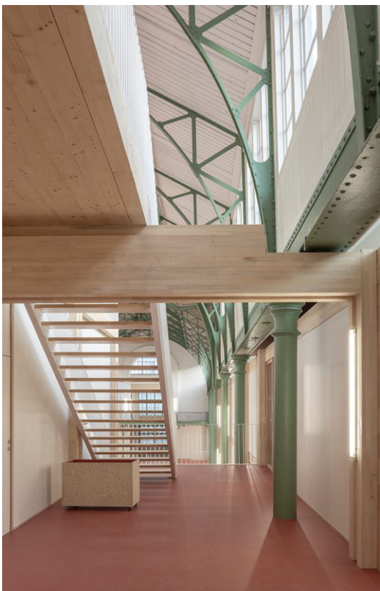
b. Pormenor de uma viga em MLC
