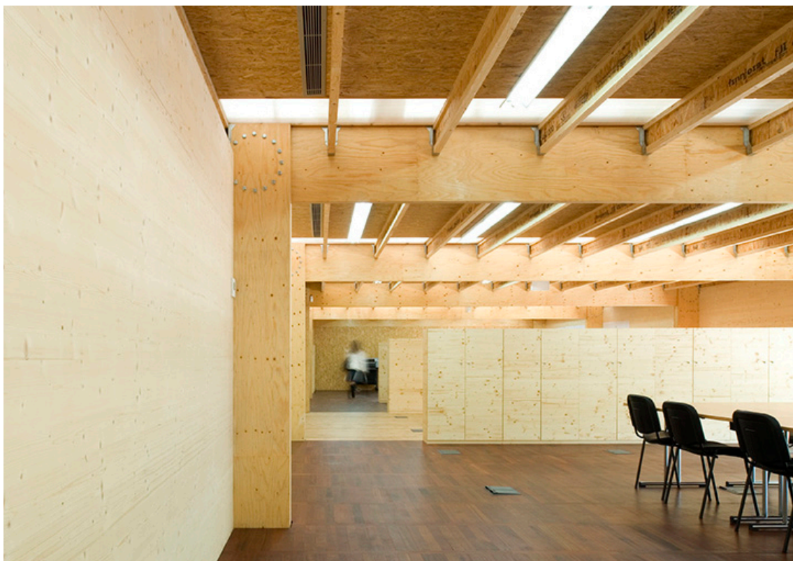
Figura 40 - Viga I utilizada também como elemento decorativo
