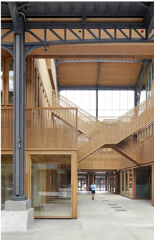
b. Pormenor da nova construção em conjunto com antiga
