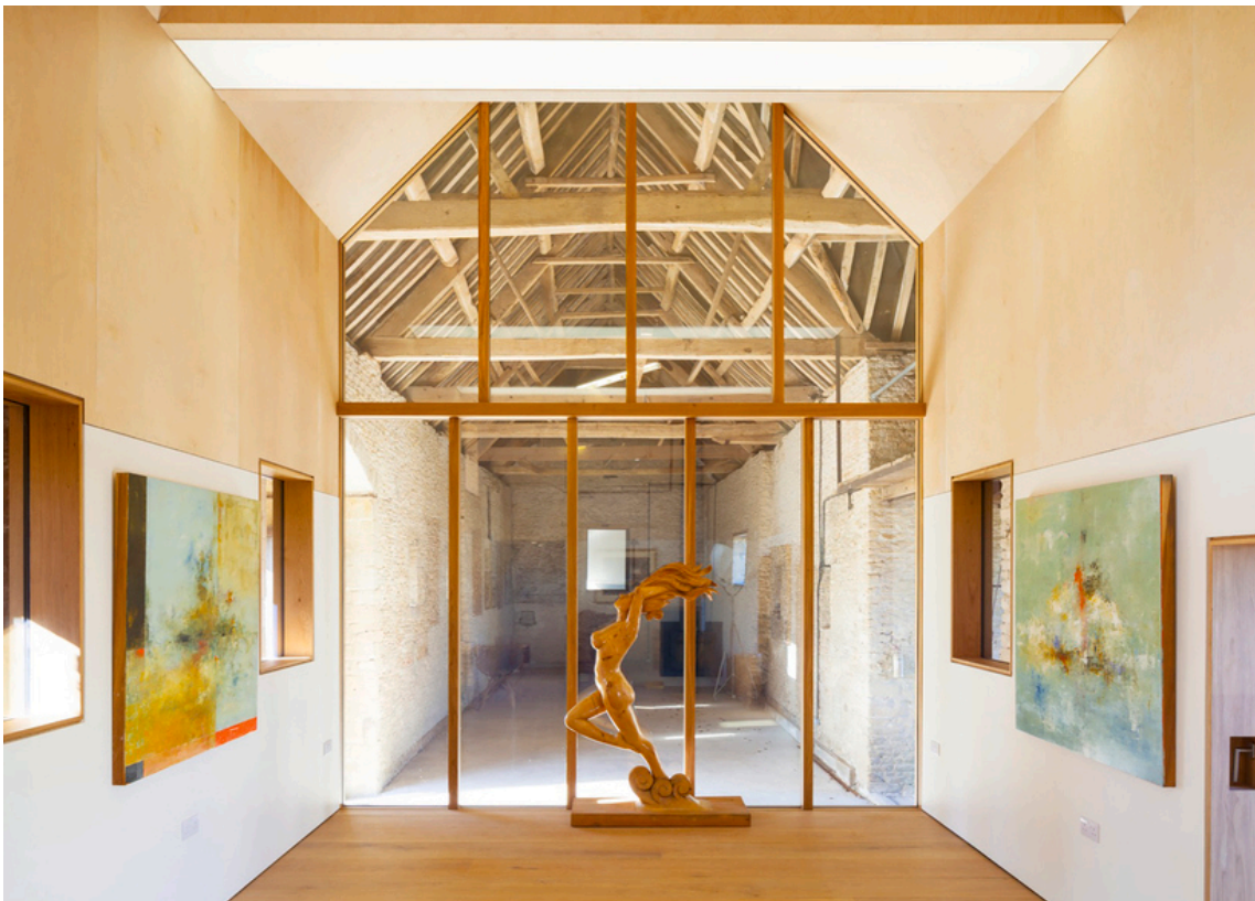
Figura 04 - Intervenção reversível dentro de um celeiro existente com o uso da madeira (novo dentro do existente)
