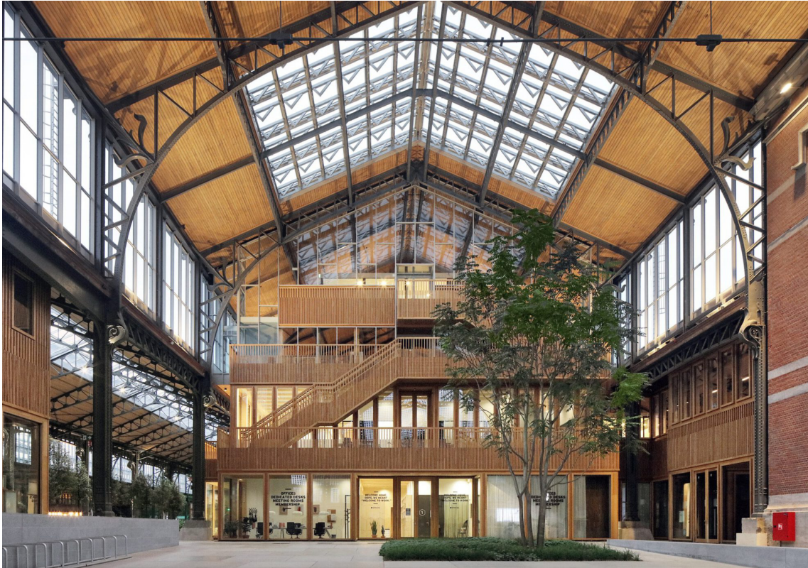
a. Nova construção em CLT montada dentro de um edifício, preservando assim a sua identidade
