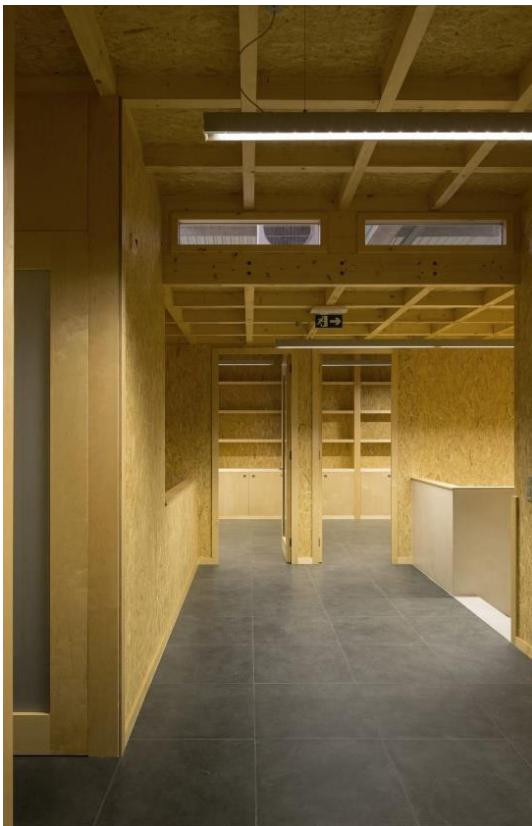
b. Uso do OSB como revestimento de paredes e portas
