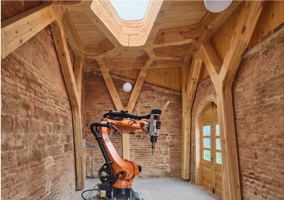
Figura 45 - Criação de uma nova estrutura em CLT num edifício existente
