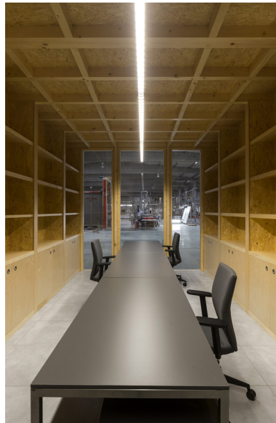
c. Utilização de OSB no mobiliário e na laje de piso
