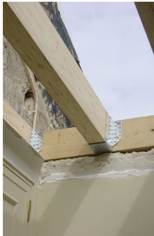
Figura 15 - Exemplo de uma ligação metálica
