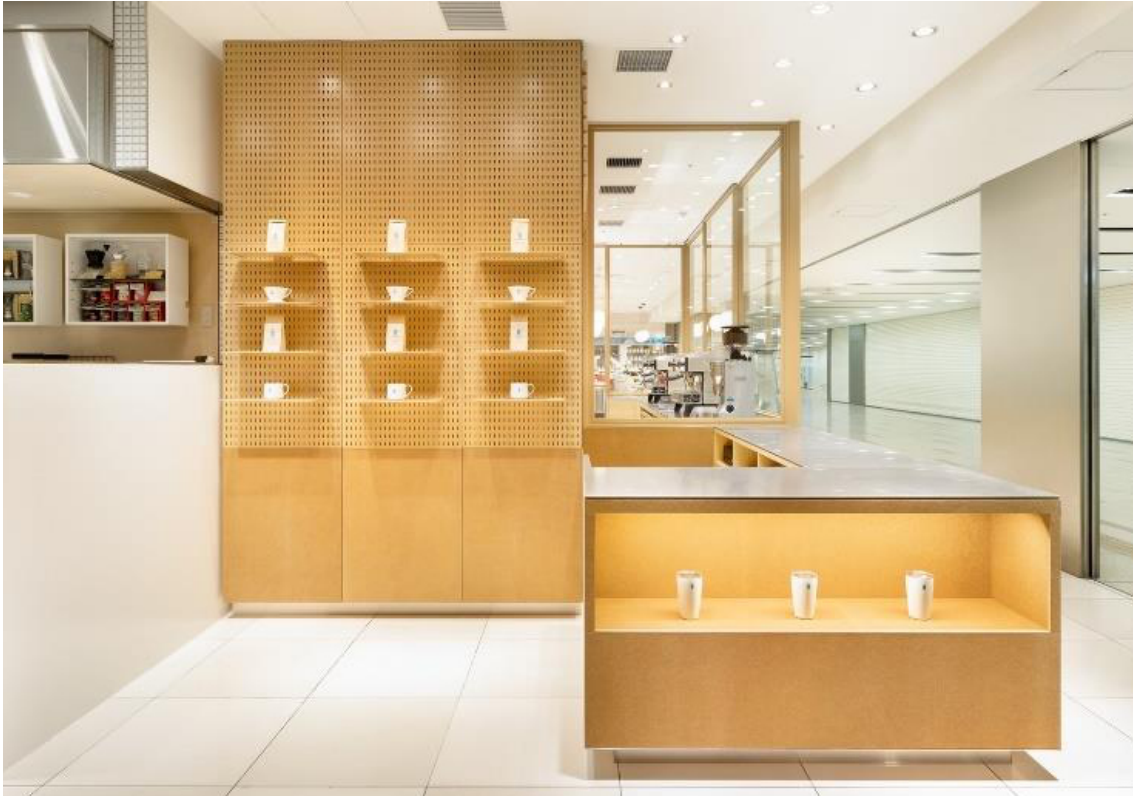
a. Uso do HDF no mobiliário e no revestimento da parede com painéis que suportar prateleiras
