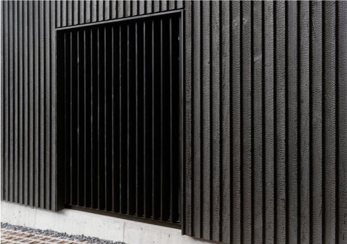
Figura 11 - Técnica de carbonização da madeira
