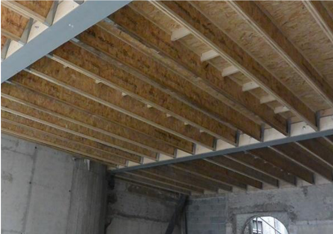
a. Pavimento composto por vigas I
