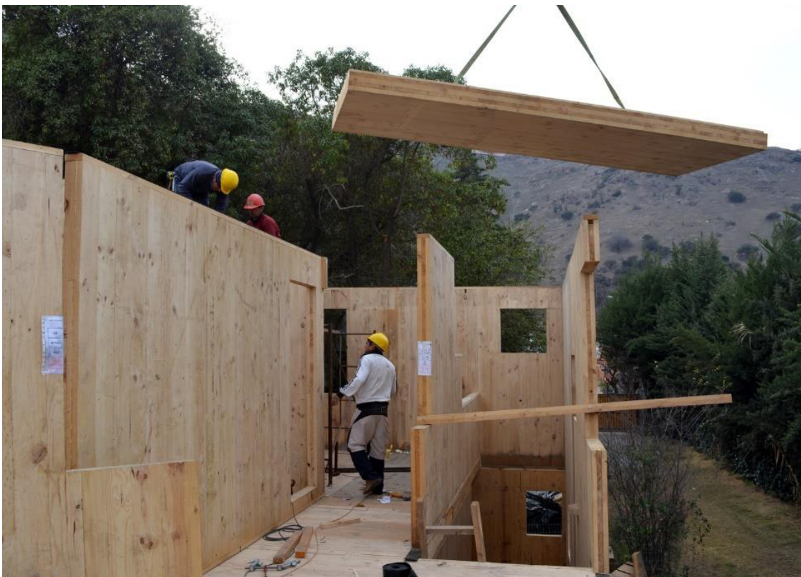
Figura 44 - Montagem de painéis de CLT para paredes e pisos
