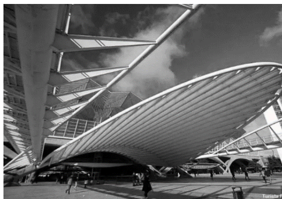
Figura 12- Garantia dos atravessamentos e continuidade urbana, Gare do Oriente, Lisboa.
