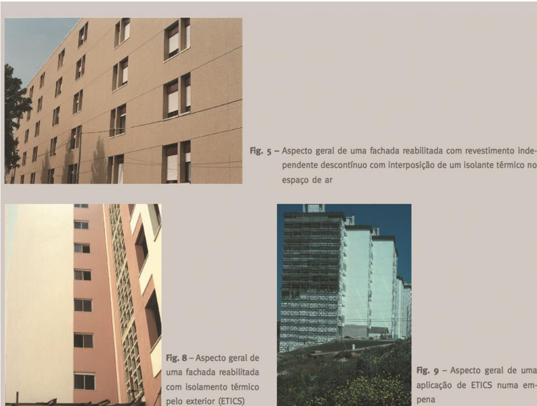
Figura 24 - Fachadas de edifícios de habitação com a aplicação de isolamento térmico tipo ETICS
