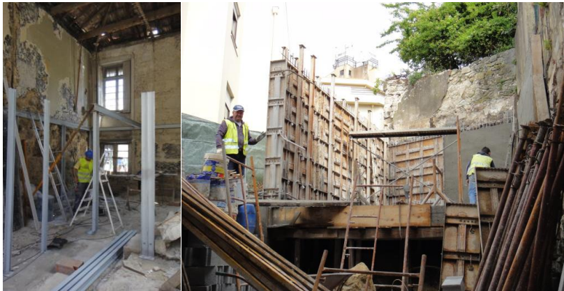
Figura 52 - Colocação da estrutura metálica e estrutura em betão armado do anexo
