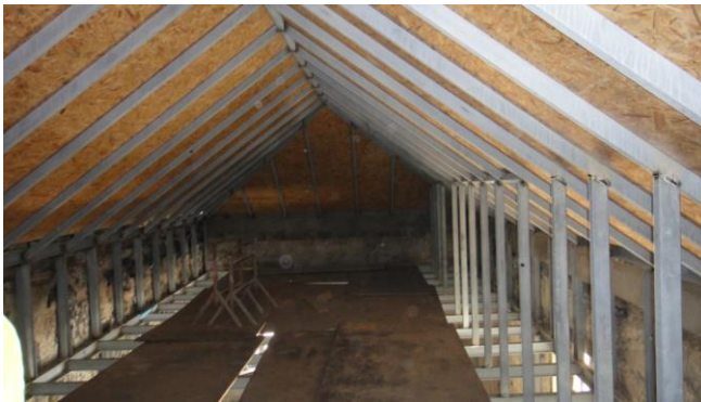
Figura 53 - Cobertura do edifício
