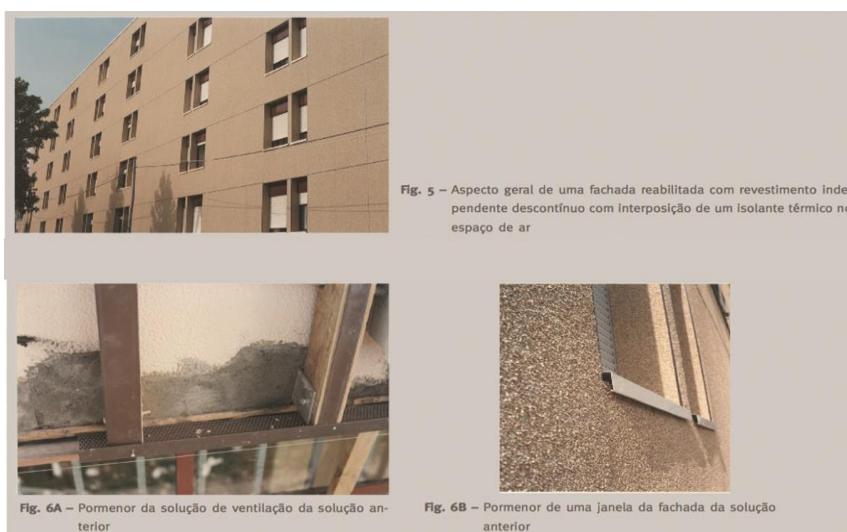
Figura 22 - Fachada reabilitada e pormenores com isolamento térmico no espaço de ar
