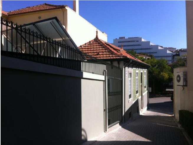
Figura 61 - Coletores solares instalados na cobertura do anexo
