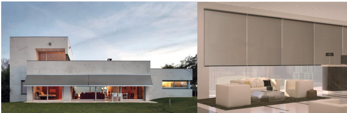
Figura 42 - Sistema de sombreamento pelo exterior e interior
