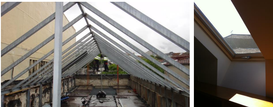
Figura 54 - Estrutura da cobertura do edifício e pormenor de clarabóia
