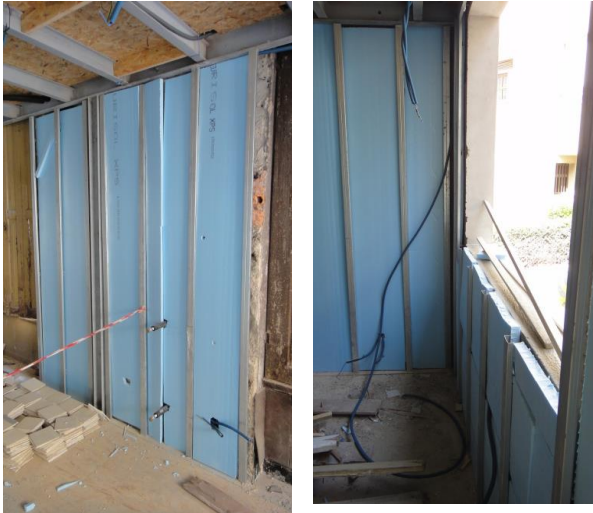
Figura 59 - "Wallmate" colocado nas paredes interiores do R/C e colocação do "Wallmate" na parede PE.01
