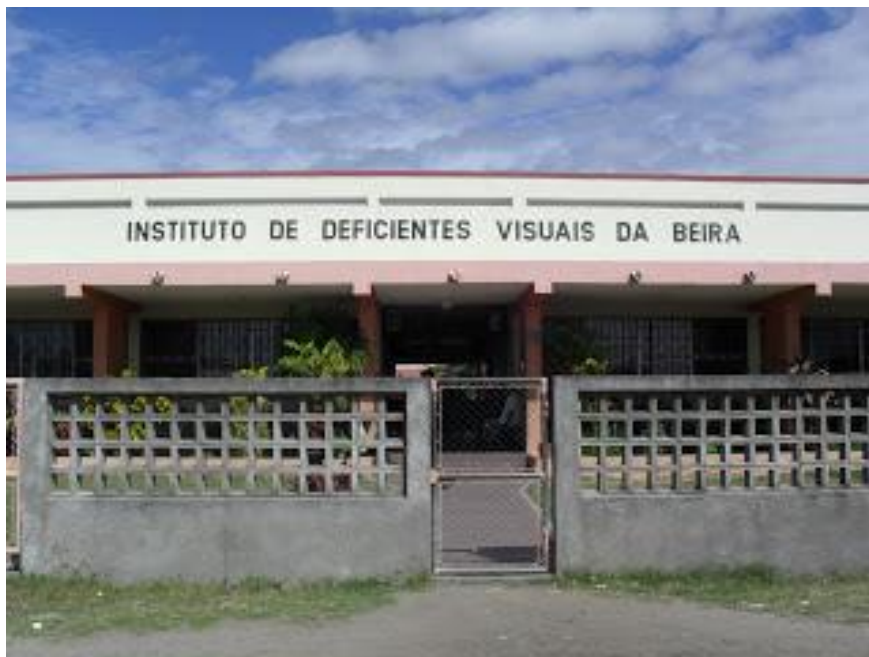
Figura 25 – Instituto de Deficientes Visuais da Beira – Moçambique.
