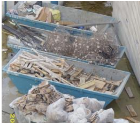
Figura n.º III. 23: Parque de resíduos em estaleiro de obra
