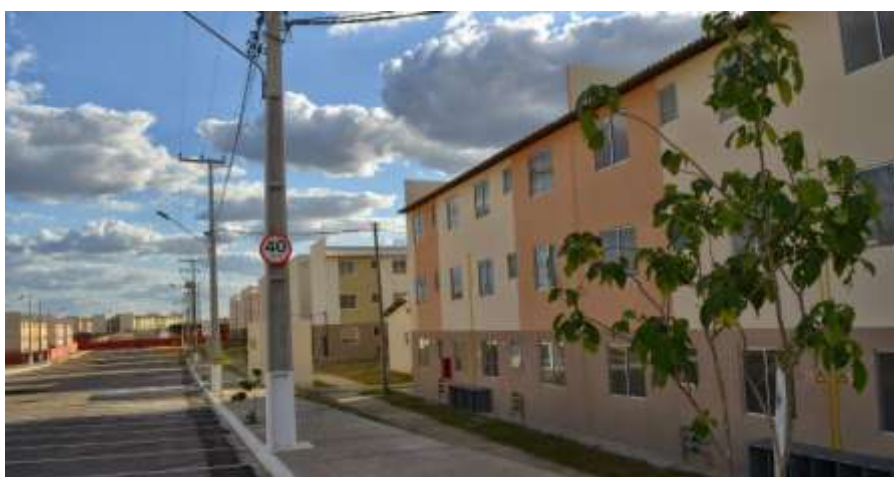
Figura 1. Residencial Nova Caiçara – Sobral - Ce
