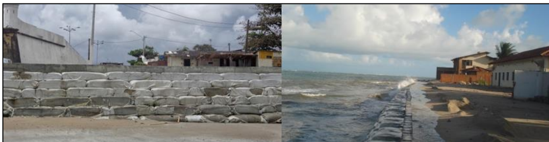
Figura 4A e B - "Rip-raps" com material ensacado em Paulista (PE) e no município de Barra de Santo Antônio – AL Fonte: Lyra, M. (2012-2015).
