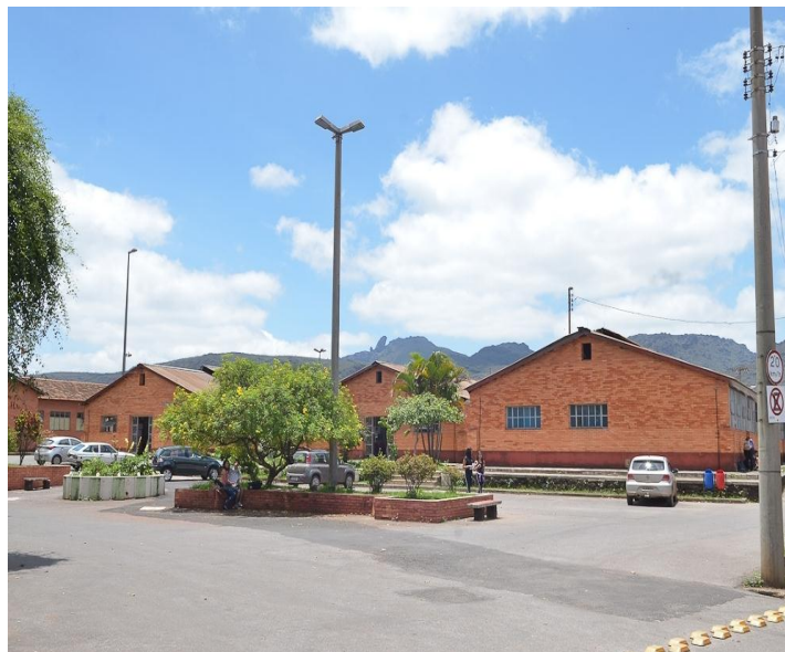
Figura 9 - Prédio da Diretoria de Ensino e Pedagogia do IFMG, campus Ouro Preto.
