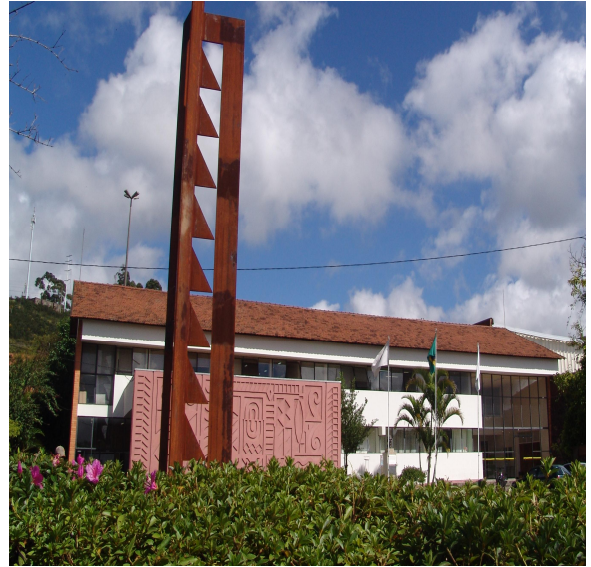
Figura 8 - Prédio da administração do IFMG, campus Ouro Preto.
