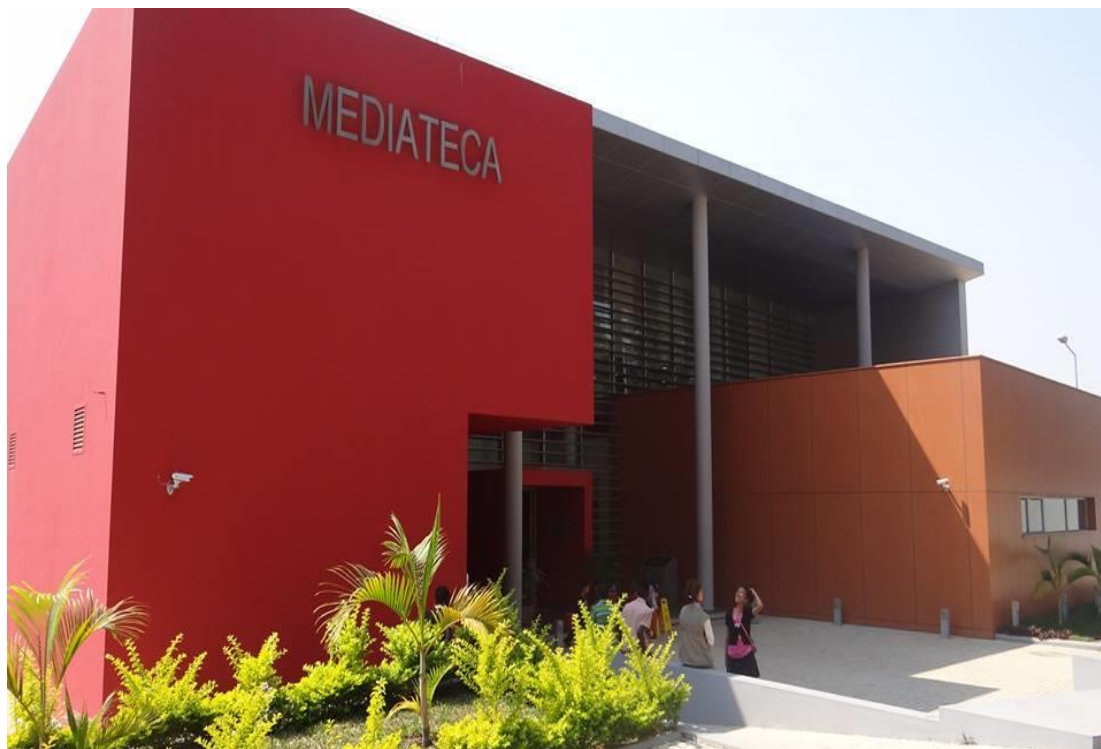
Figura 32 – Apresentação do Edifício da Mediateca do Huambo.
