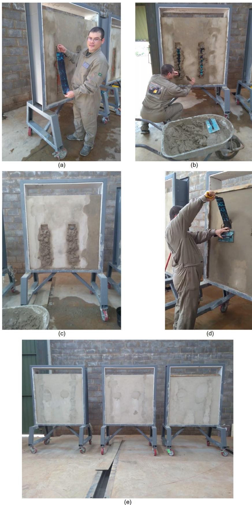
Figura 62 – Simulação de deslocamento de reboco.
