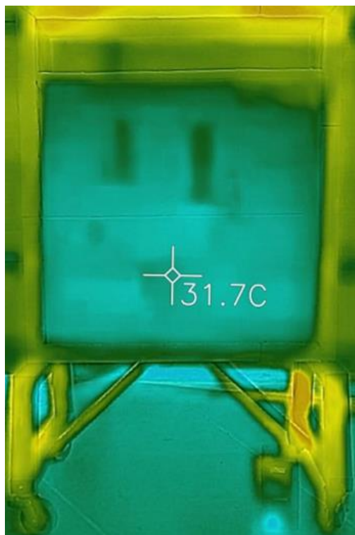
Figura 72 – Desplacamento de revestimento cerâmico brilhoso com CTBRA. Fonte: o autor.
