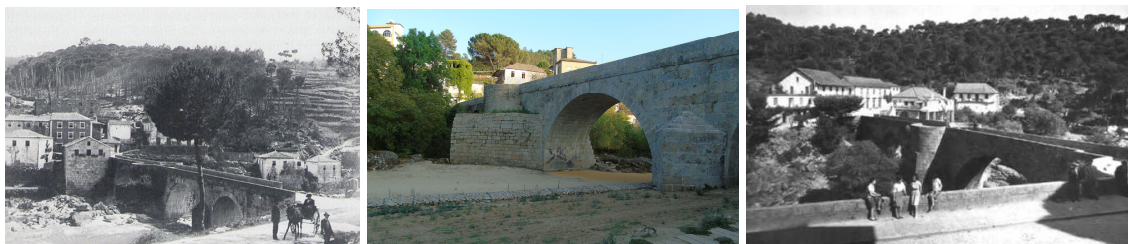
Figura 6,7 e 8 – Ponte e encosta do lado Mangualde, 1927; Lado da ponte voltado para montante; Ponte e encosta do lado de Visu, 1963.
