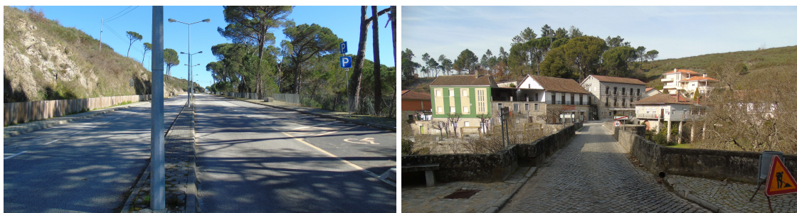
Figura 9 e 10 – Troço reto da EM 594 e Ponte, com os edifícios do lado de Viseu.
