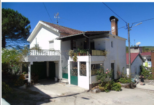
fachadas nascente e sul
