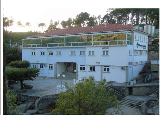
fachadas sul e nascente
