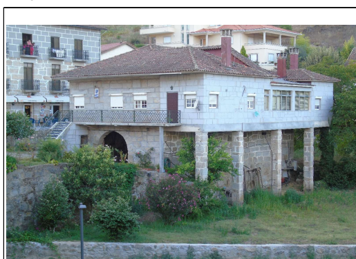
fachadas nascente e sul
