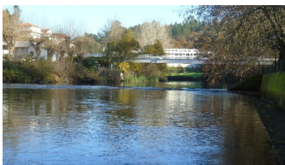
Figura 42 – Passadiço submerso e ponte pedestre.
