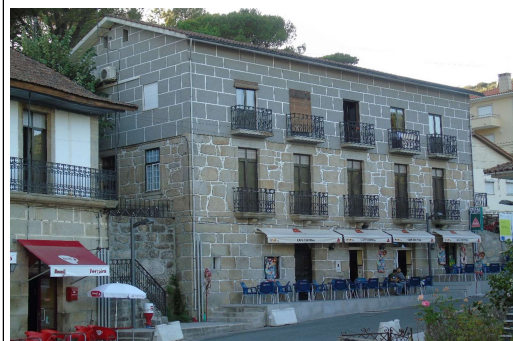
fachadas sul e nascente
