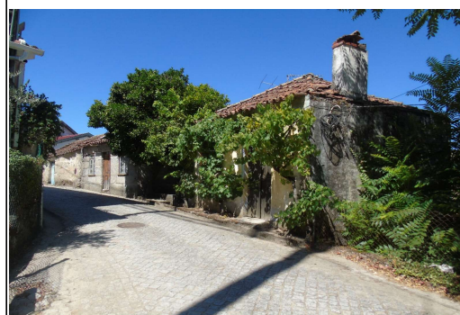
fachadas sul e nascente
