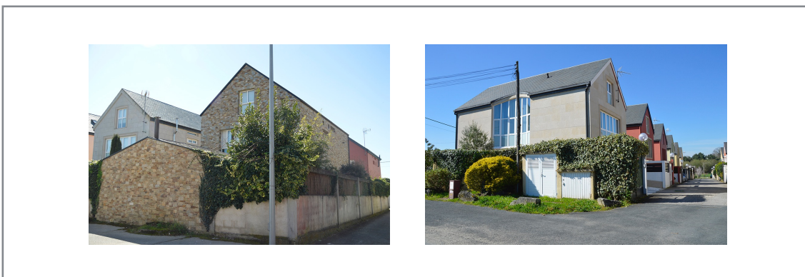
Figura 3.33. Estado actual de la obra: Modificaciones sobre el acabado original de las viviendas y estado de las calles. Fuente: Fotografía del Autor.
