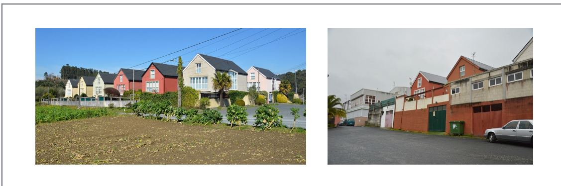
Figura 3.32. Estado actual de la obra: Vista del perímetro sur y norte del conjunto edificado. Fuente: Fotografía del Autor.
