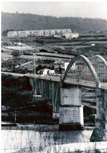
Figura 3.28 Vista del puente do Pedrido y la urbanización Montecelo al fondo. Fuente:Revista Obradoiro Nº18 (1991)
