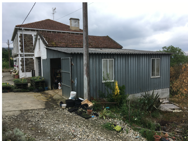
Figura 2.27 Pequeños talleres, como la carpintería de la fotografía, o construcciones relacionadas con actividades agrarias (invernaderos, granjas, alpendres...), son las edificaciones no residenciales, vinculadas a actividades más frecuentes en Paderne. Fuente: Fotografías del Autor.
