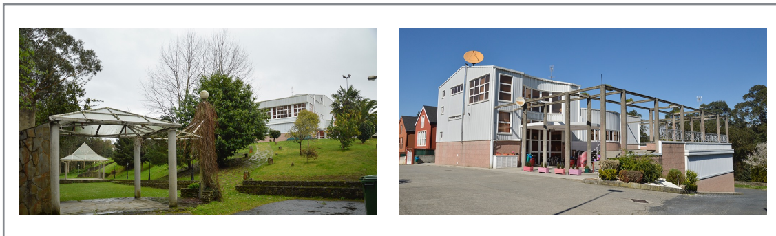
Figura 3.31. Estado actual de la obra: Espacio público ajardinado con el Centro social, sede de la AV San Pantaleón. Centro Social visto desde una calle interior. Fuente: Fotografía del Autor.
