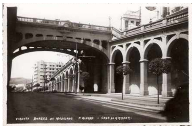
Figura 3 - Viaduto Borges de Medeiros - Porto Alegre, 1935 - Foto: Casa do Amador
