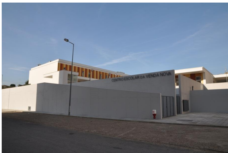
Figura 7. - Foto do Fachada principal do Edifício
