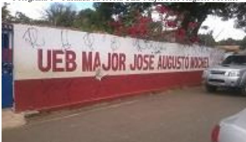
Fotografia 1 – Fachada da escola UEB Major José Augusto Mochel
