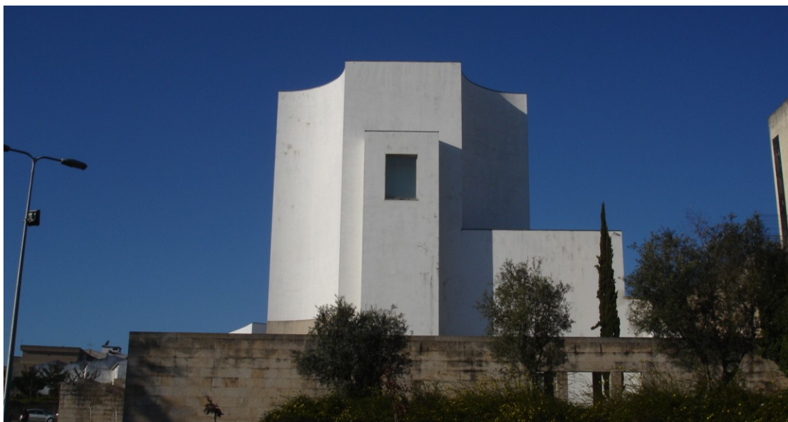
Fig. 55 – Álvaro Siza Vieira, Corpo Branco sobre a base de Granito (Fachada Nordeste) da Igreja de Santa Maria, Marco de Canaveses, (1990-96). 88
