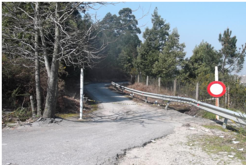
Figura 49 - Estrada nacional EN208, troço abandonado em Valongo
