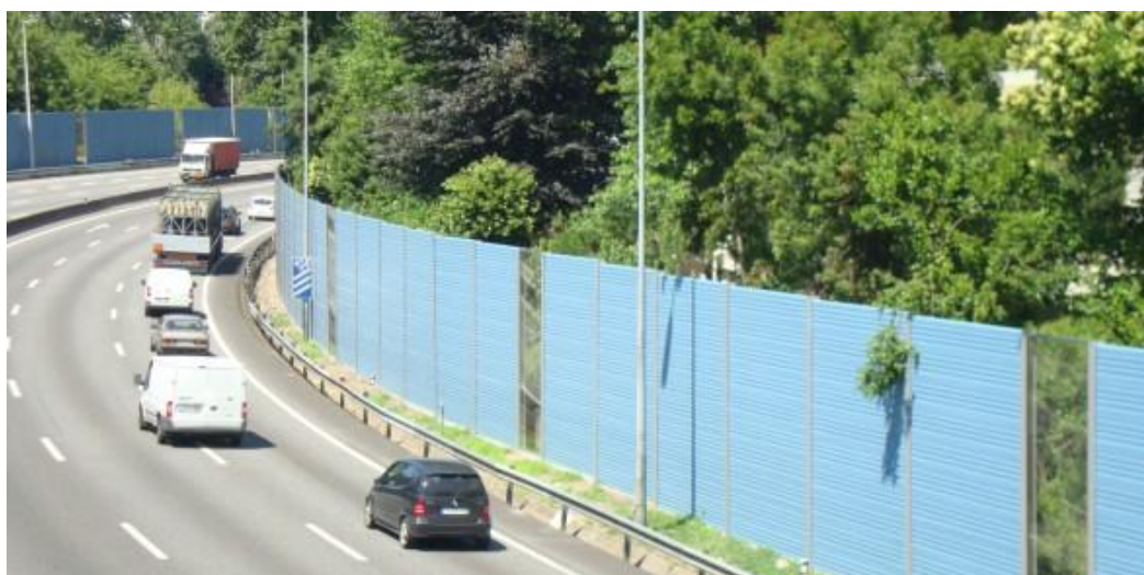
Figura 23 - Barreira acústica aplicada no lanço da A28/IC1, Boavista
