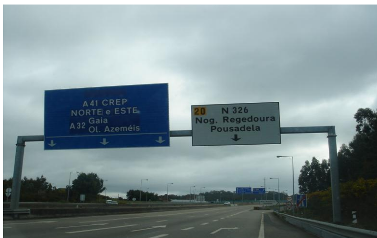
Figura 63 - Sinais de pré-sinalização e marca rodoviária na A1, A41/IC24
