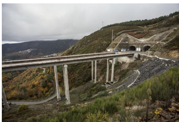
Figura 38 - Túnel do Marão
