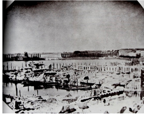
Fig. 01 – Escombros após incêndio em Hamburgo, de Carl Stelzner, 1842. (Lacayo e Russel, 1995, p. 18)
