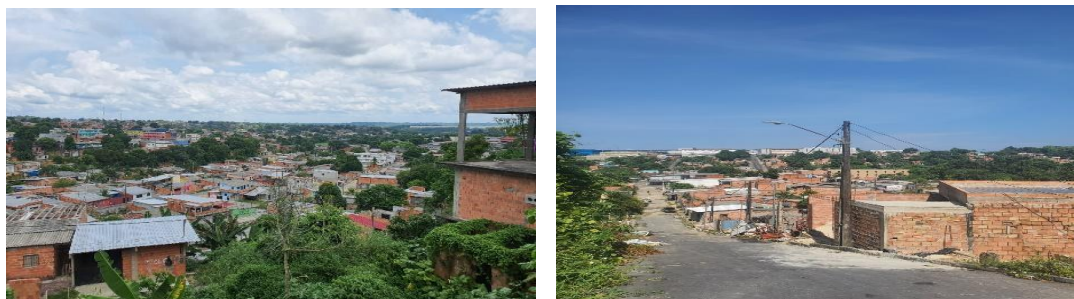
Figura 6a e 6b- Vista parcial da comunidade Parque São Pedro e Jesus me Deu, respectivamente Fonte: Foto autor/2022
