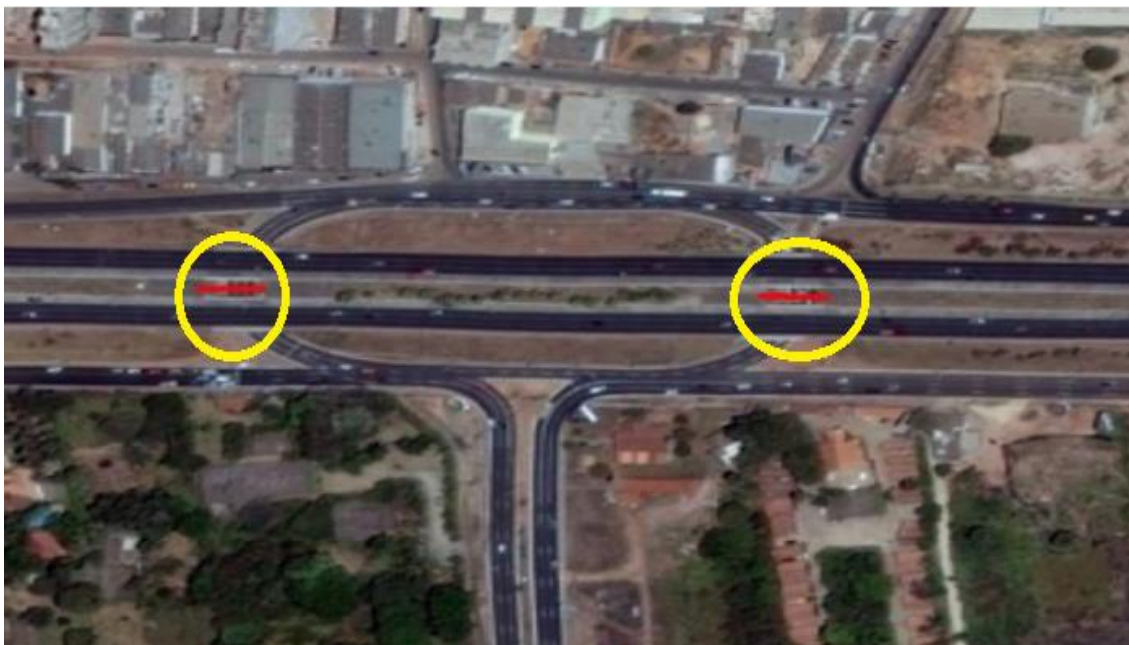
Figura 11. Localização das obras de arte especiais (Viaduto Israel Pinheiro)
