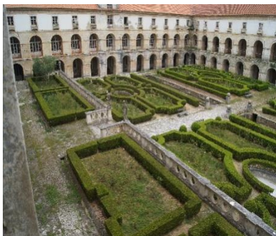
Figura 15 - Claustro interior do Mosteiro Cisterciense de Alcobaça 53 [04-07-2014] Copygrith © Carlos Miguel Rodrigues
