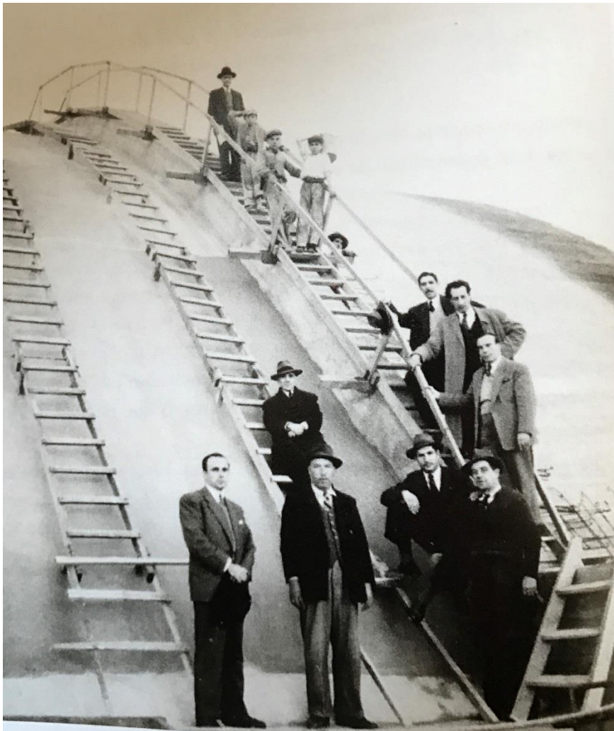
fig. 5 – Foto tirada durante as obras do mercado de Matosinhos
