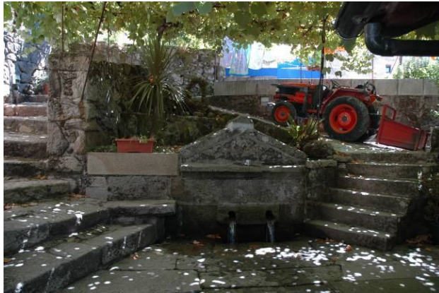
Ilustração 10: Chafariz de Lindoso-Ponte da Barca-PT
