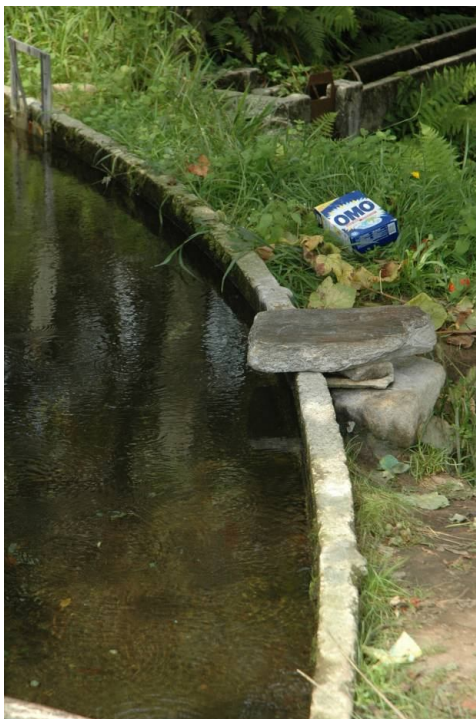
Ilustração 103: Lavadouro junto ao canal de rega. Tenães-Estaorãos-Ponte de Lima
