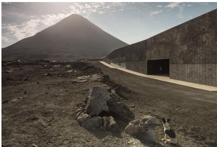
Figura 57 - Exposição solar no edifício.
