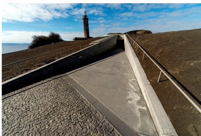
Figura 29 - Centro Interpretativo do vulcão dos Capelinhos, Ilha do Faial.
