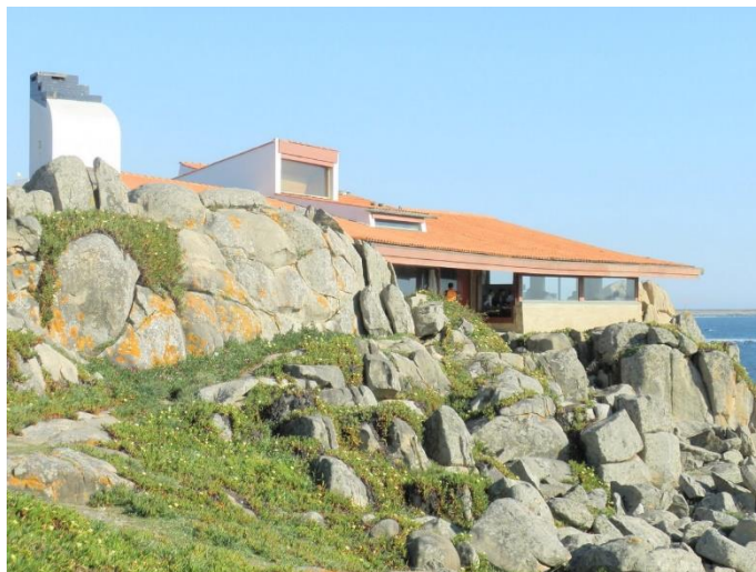
Figura 17 - Casa de chá; Leça da Palmeira.
