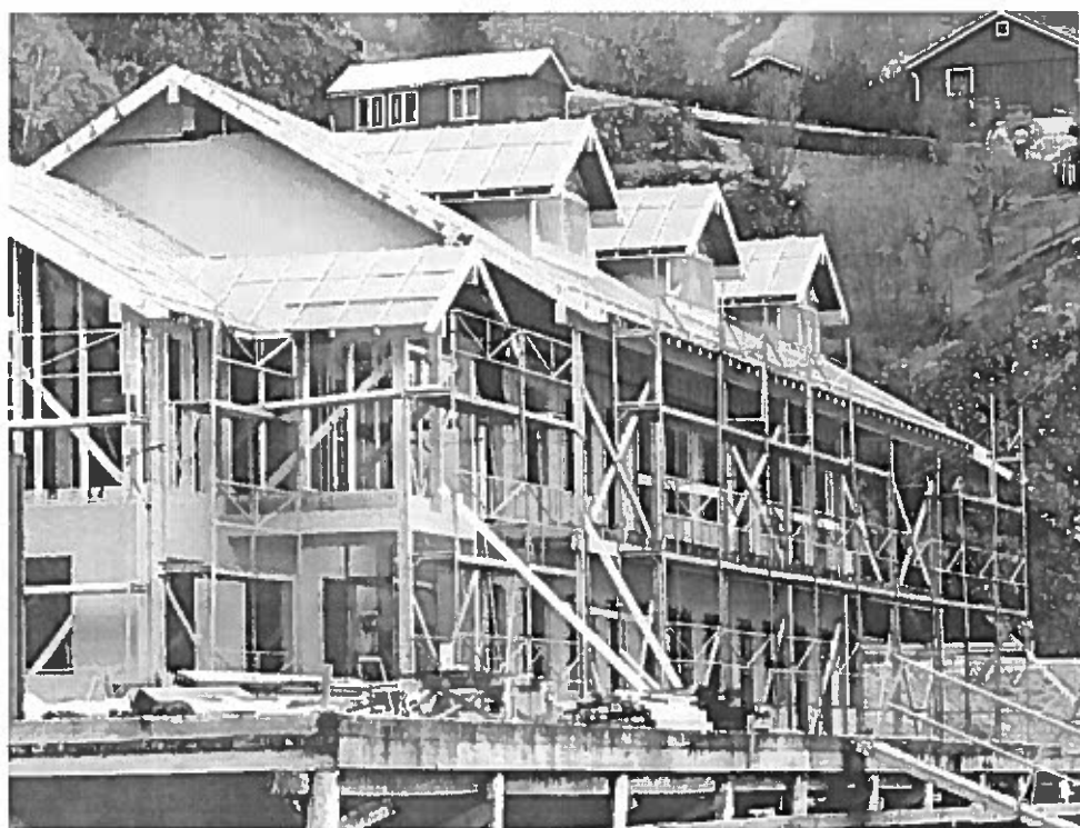
Figura 7.3 – Vivenda em construção
