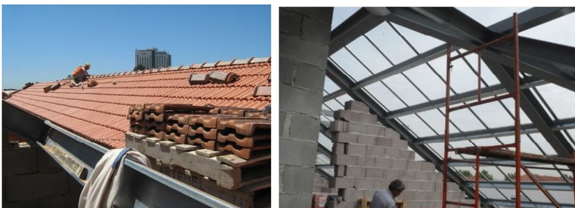
Figura 31 – Reposição de Telha Marselha (1918) e Estrutura Metálica do Telhado, antes de Receber o Isolamento (1916)
