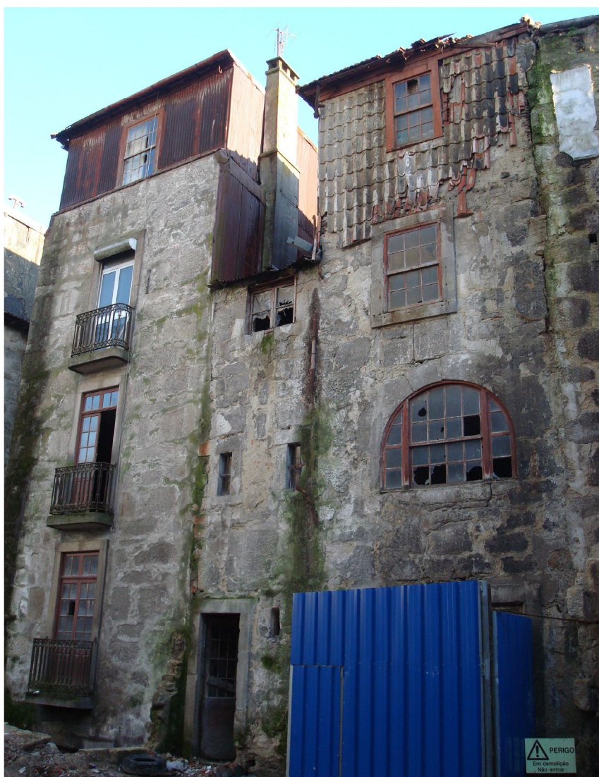
Figura 16 – Exemplos de Revestimentos em Acrescentos, em Chapa e Telha a Prumo.
