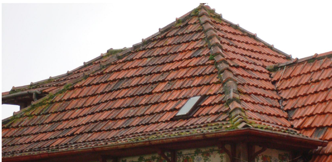
Figura 8 – Postigo no Telhado
