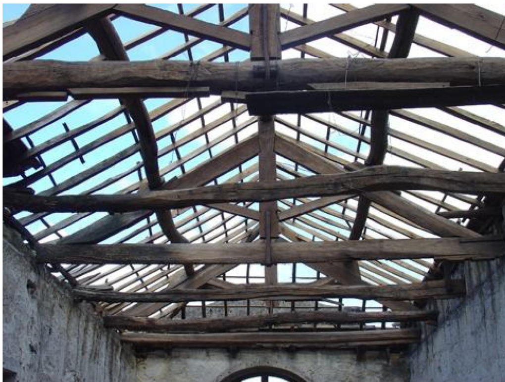
Figura 5 – Estrutura Interna de Telhado de Quatro Águas.
