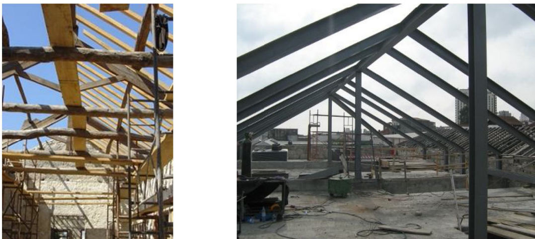
Figura 30 – Substituição de Elementos Danificados na Estrutura de Madeira (1918) e Construção da Estrutura Metálica do Telhado (1916)
