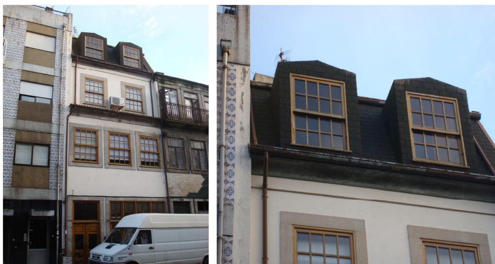
Figura 7 – Telhado em Mansarda Reabilitado.
