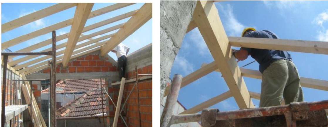
Figura 44 – Trabalhos de Construção da Estrutura do Telhado em Madeira.
