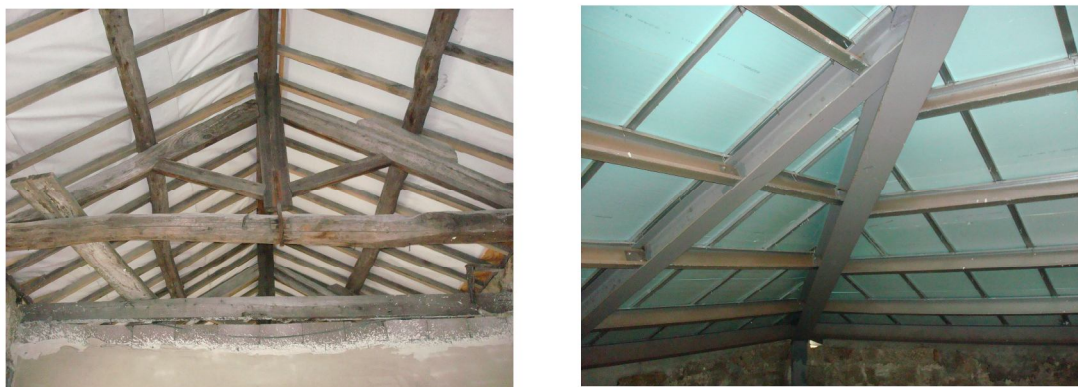
Figura 32 – Finalização das Estruturas antes dos Acabamentos Finais
