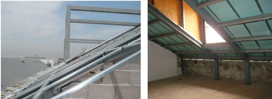
Figura 34 A e 34 B – Armação Metálica Exterior da Trapeira e Vista Interior já com Isolamento.
