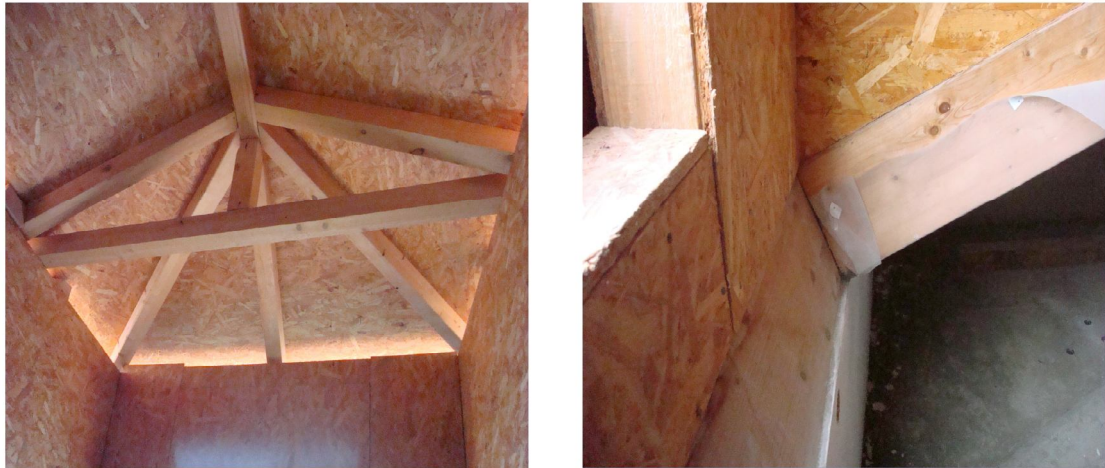
Figura 48A e 48B – Pormenores da Armação da Trapeira.
