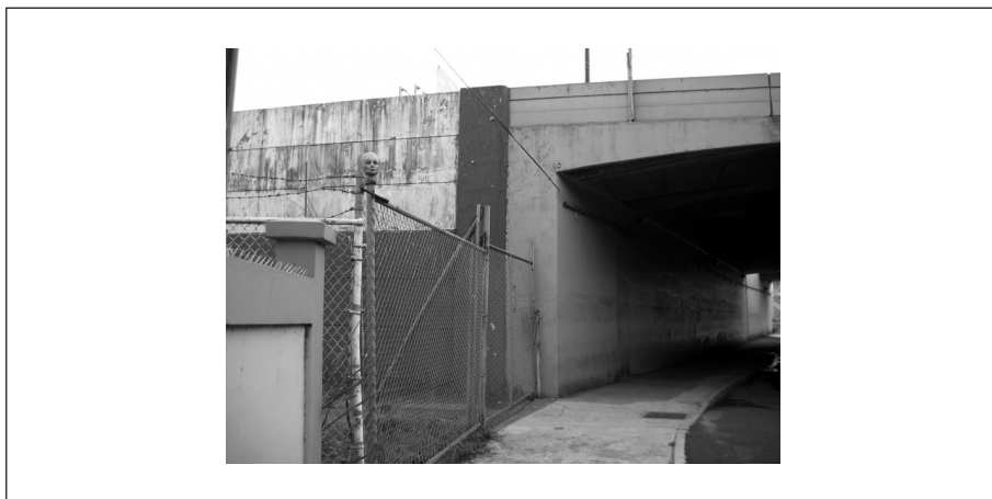
Foto 4 - Puente de la calle Canals.
