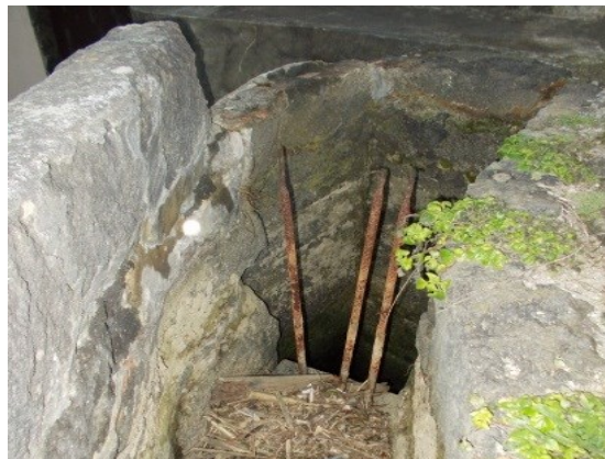
Figura 43 – Grade na entrada do cubo (Fonte: do autor)
