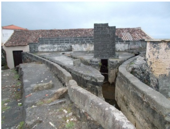
Figura 42 – Canais derivação da levada para os cubos (Fonte: do autor)
