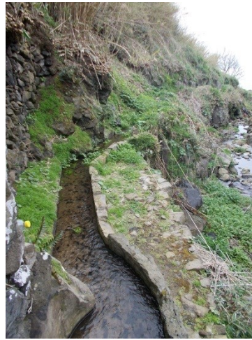
Figura 15 - Levada em pedra de basalto irregulares (Fonte: do autor)
