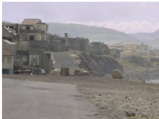
Figura 45 – Habitação degradada na costa marítima (Fonte: do autor)
