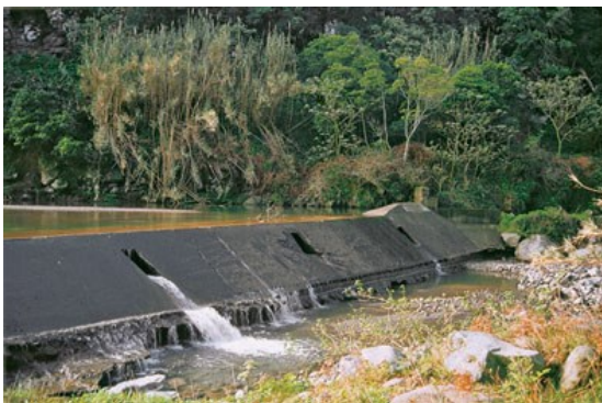
Figuras 10 - Açude que eleva o nível da água (Fonte: do autor)
