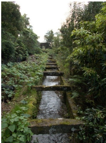
Figura 14 - Levada em pedra de basalto talhado (Fonte: do autor)
