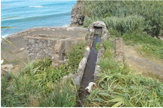
Figura 17 – Entrada direta da água da levada para o cubo (Fonte: do autor)
