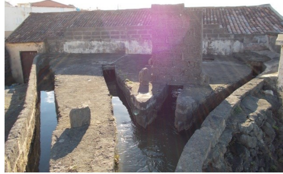
Figura 18 – Canais de derivação da levada para os cubos (Fonte: do autor)
