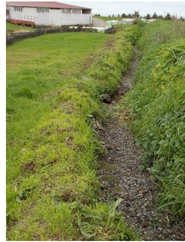
Figura 16 - Levada em simples canal ou rego em terreno firme (Fonte: do autor)
