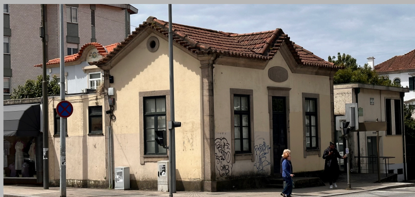
4 Figura 47 - Antiga Casa de Portagem do Amial
