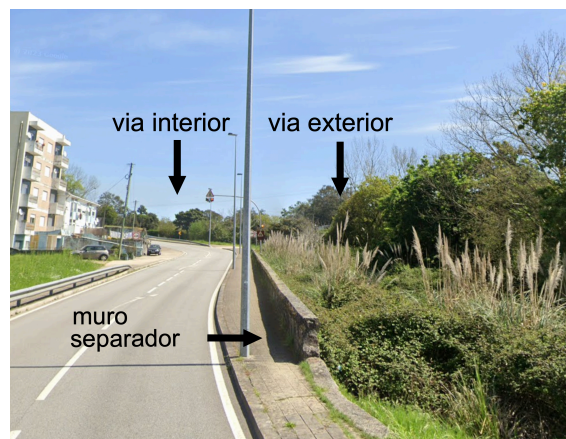
Figura 40 - Estrada Interior da Circunvalação
