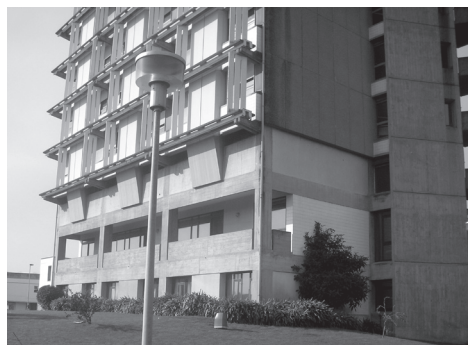
Fig.12 - Imagem do topo nascente do edifício principal
