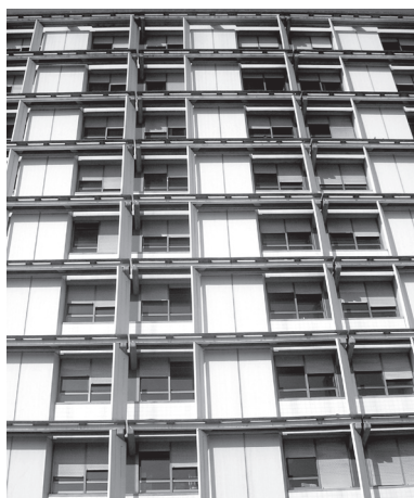
Fig.10 - Detalhe da fachada do hospital
