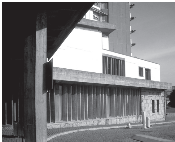
Fig.13 - Imagem da entrada principal do Hospital
