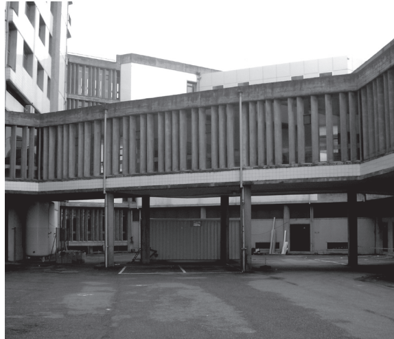
Fig. 15 – imagem de uma passagem aérea entre volumes do corpo principal
