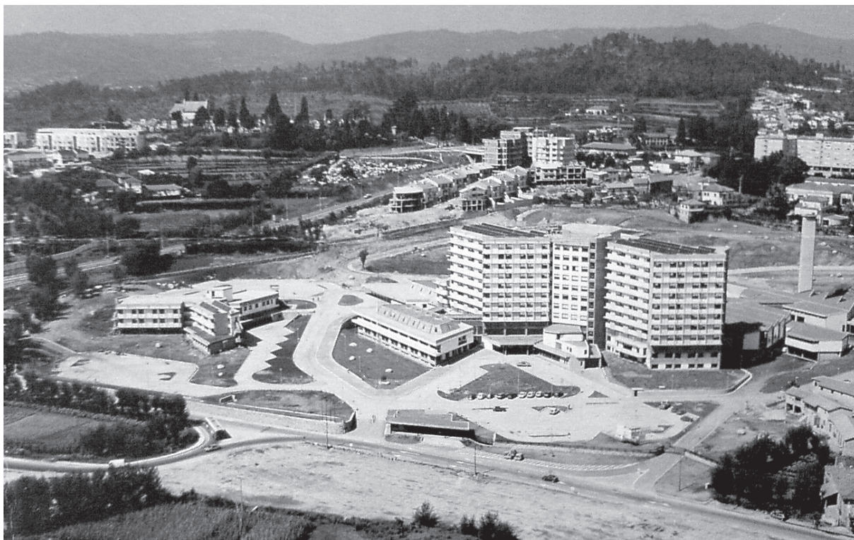
Fig. 2 - Vista aérea do hospital de Guimarães
