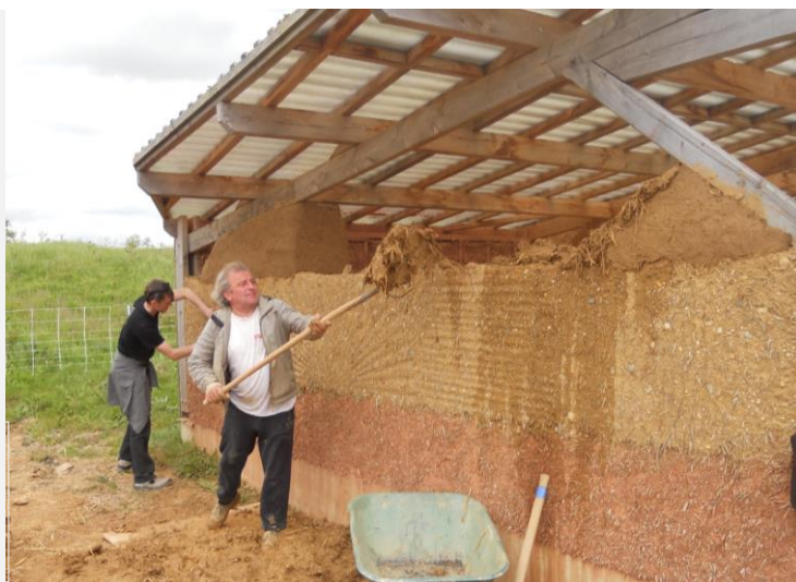
12 Execução de uma alvenaria em terra empilhada (cob). Normandia. Foto do autor
